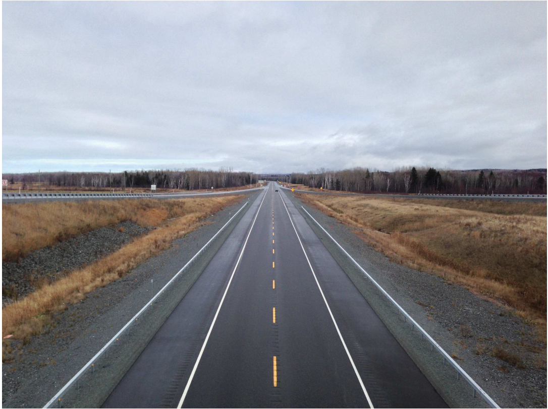
Photographie 1-1 : Vue des nouvelles voies de l'autoroute 20 à l'est de la rue Notre-Dame
