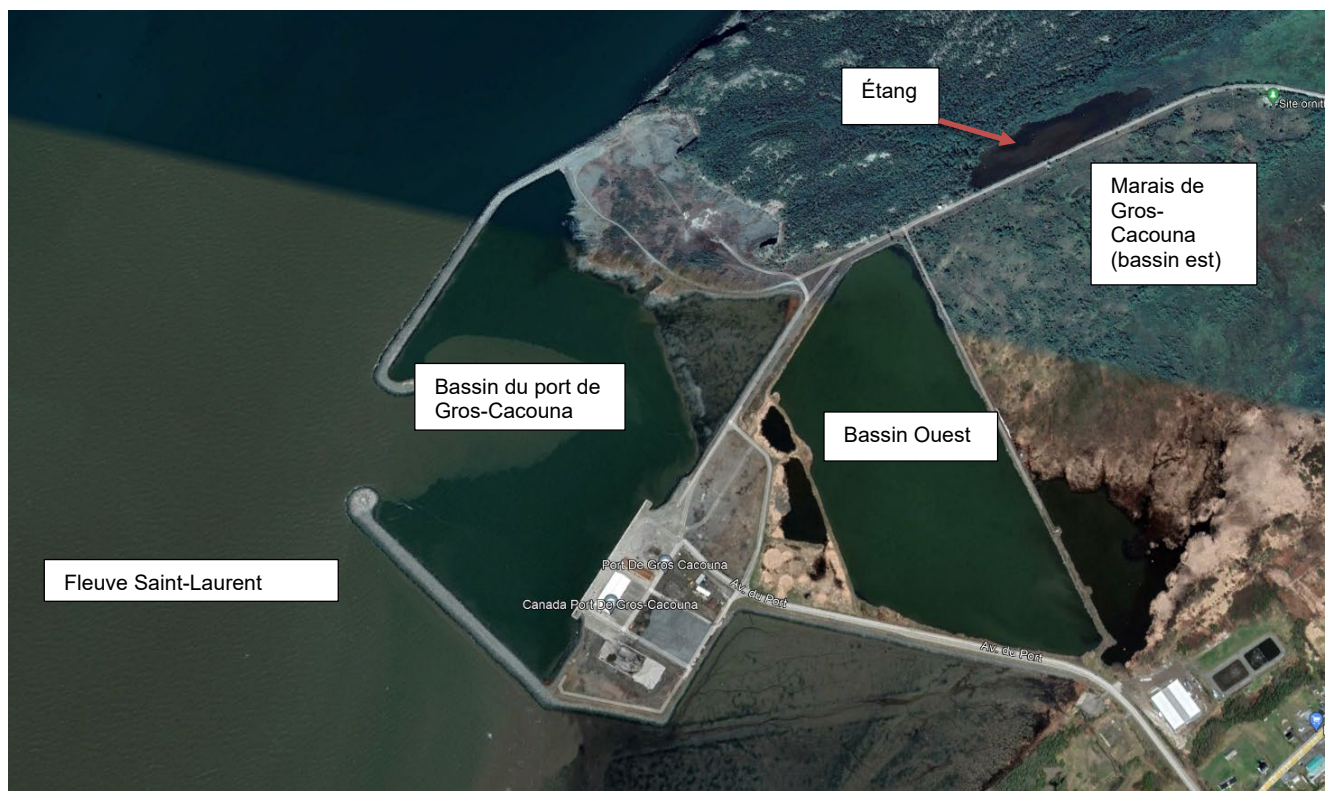
Photo 4.1 : Localisation des plans d'eau intérieurs
