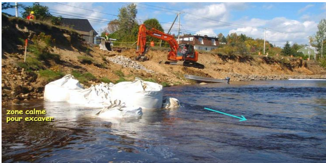
Photo 2 : Exemple de mégasacs de gravier utilisés sur la rivière Sainte-Anne en 2014
