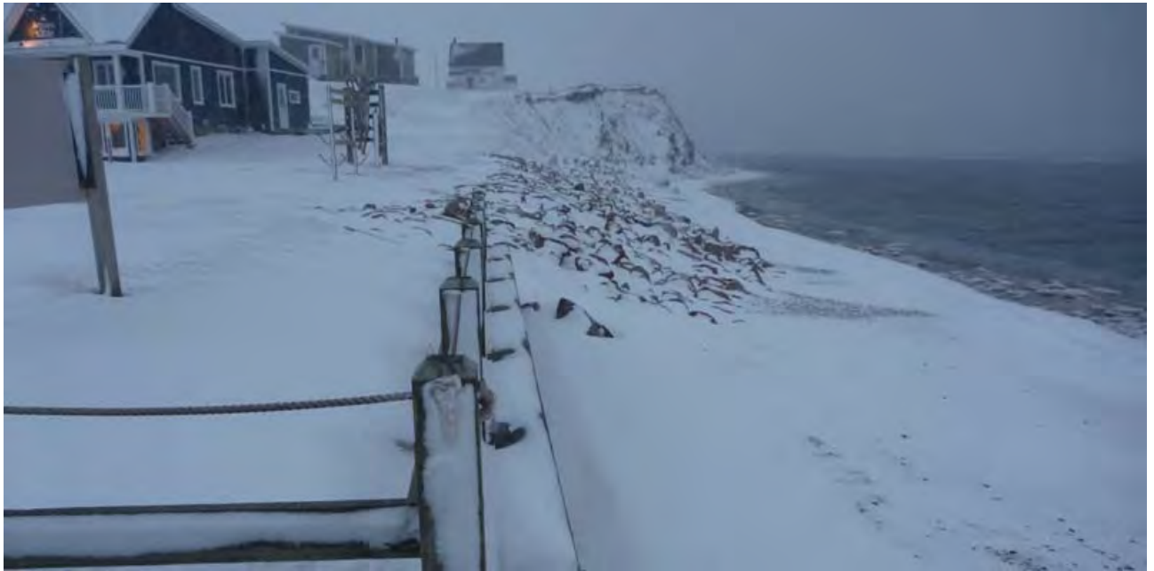
Figure 2.33 Extrémité occidentale de la plage de La Grave – Enrochement et mur
