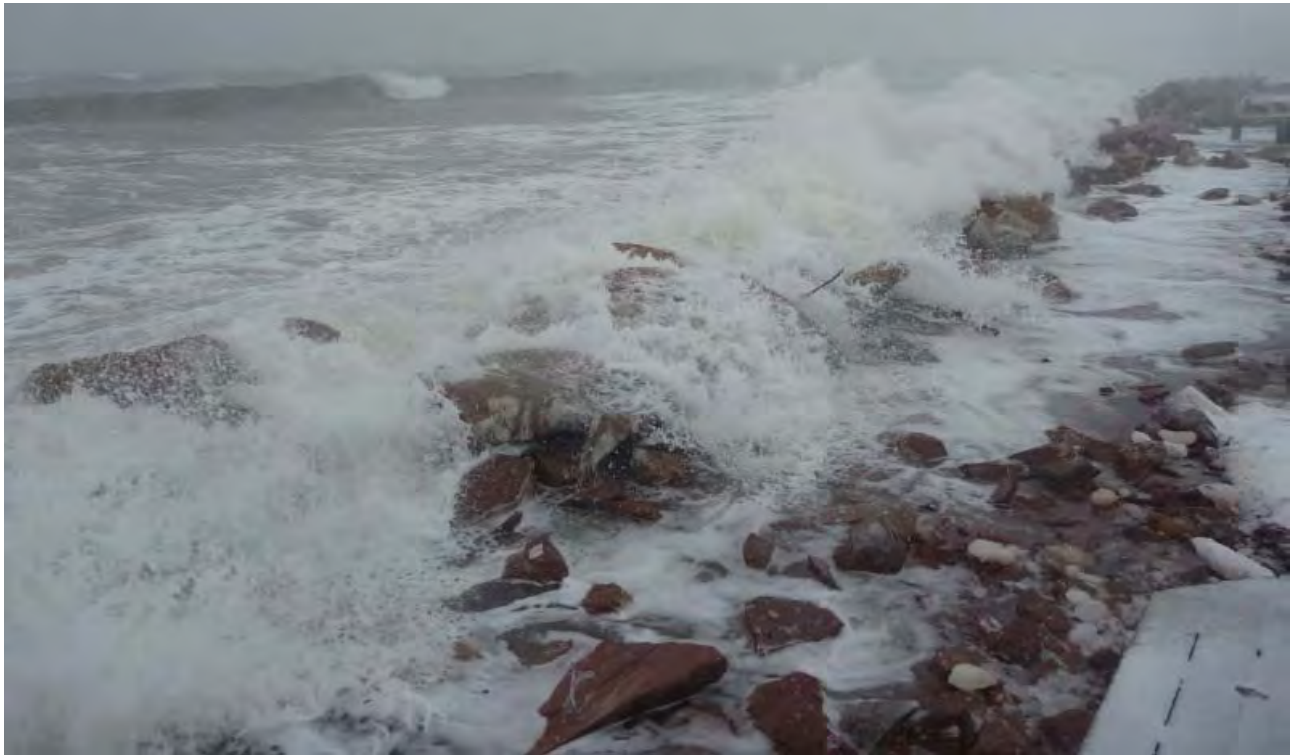
Figure 2.17 Secteur du chemin des Chalets– Tempête du 27 janvier 2011 – Franchissement par les vagues des protections en enrochement
