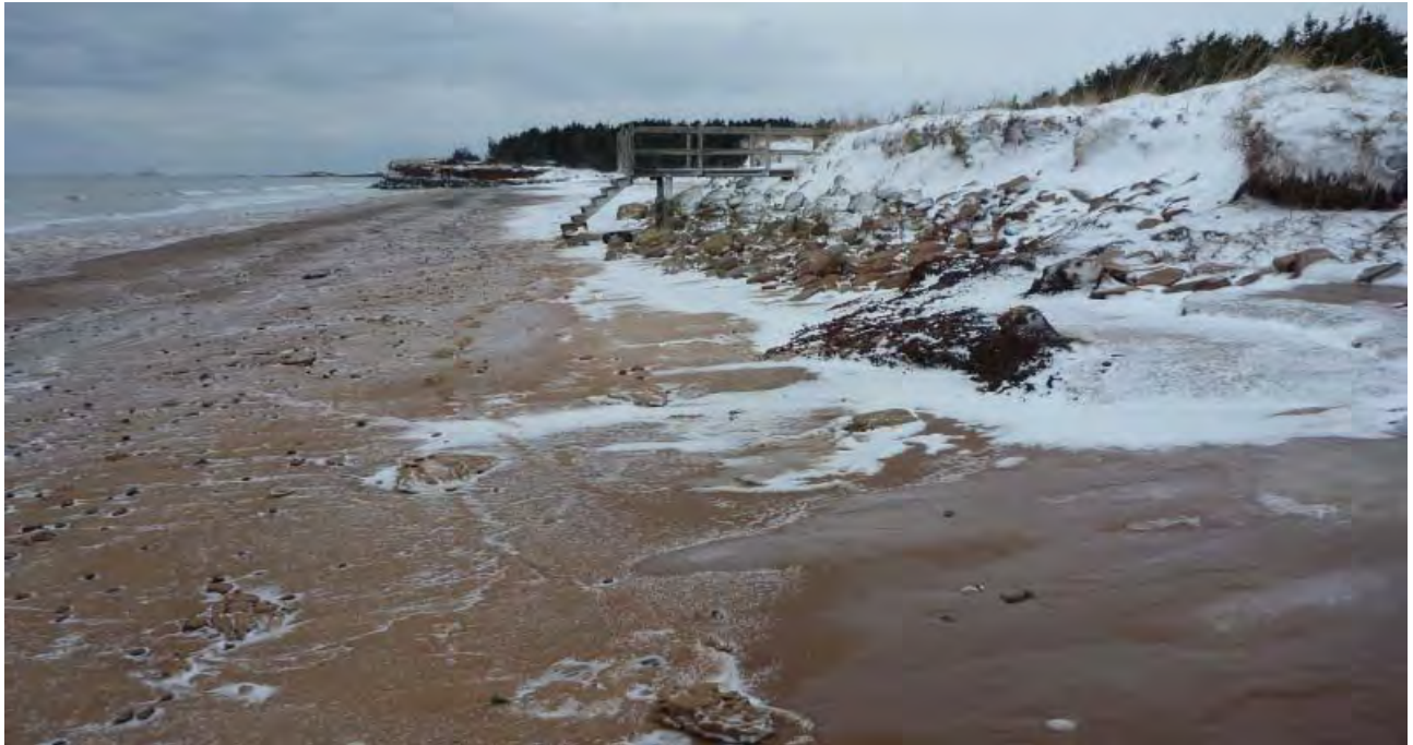
Figure 2.10 Secteur du Gros-Cap – Plage de la garderie avec sa protection partielle
