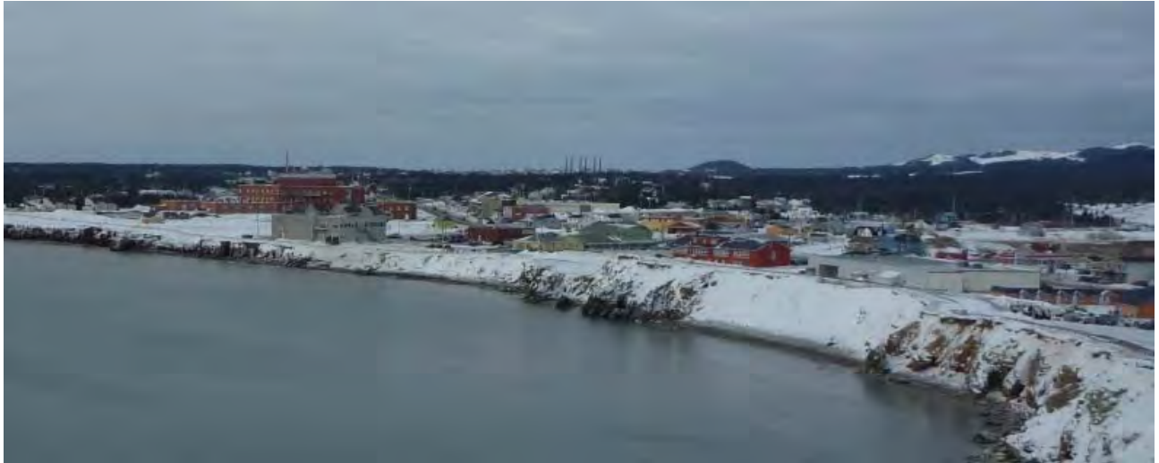
Figure 2.41 Secteur de l'hôpital – Falaises en érosion
