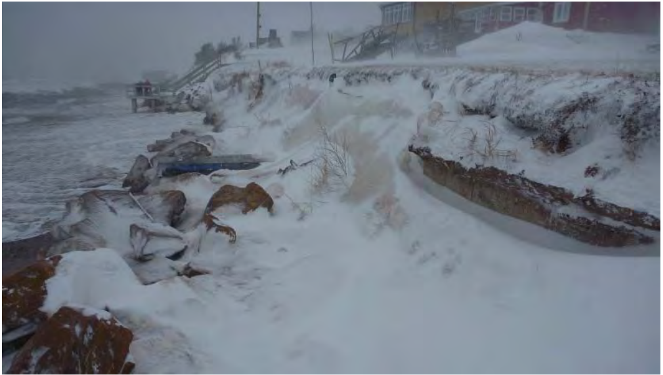
Figure 2.29 Pointe de la Martinique – Protection en enrochement inefficace (franchissement par les vagues et érosion du talus derrière l'enrochement)
