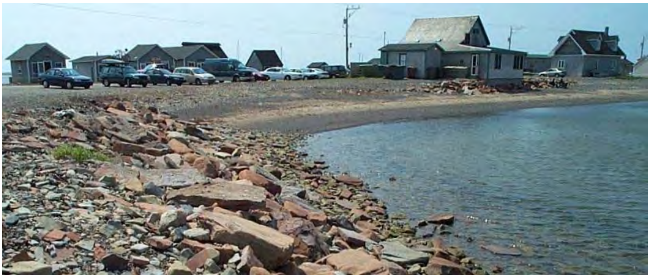
Figure 2.40 Protection de berge devant la maison la plus à l'est sur la plage de La Grave en 2002
