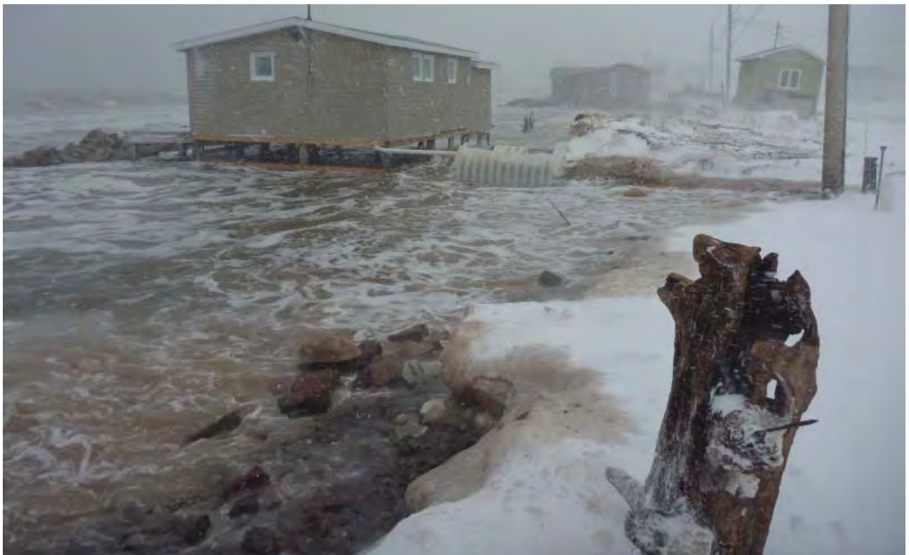
Figure 2.16 Secteur du chemin des Chalets– Tempête du 27 janvier 2011
