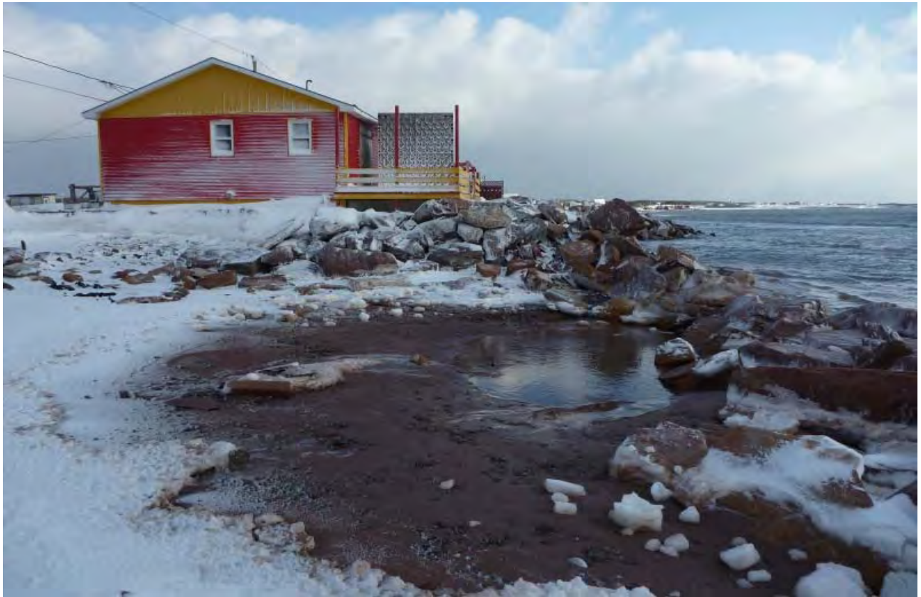
Figure 2.23 Chalet du secteur du chemin des Chalets autour duquel la dune littorale a complètement disparu, le chalet se retrouvant « en mer »
