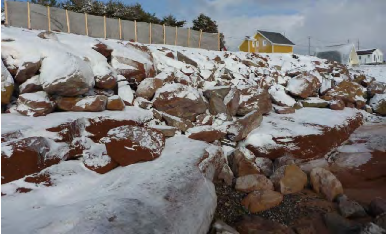
Figure 9.8 Instabilité des pierres posées directement sur du roc affleurant au pied des falaises de la Pointe de la Martinique
