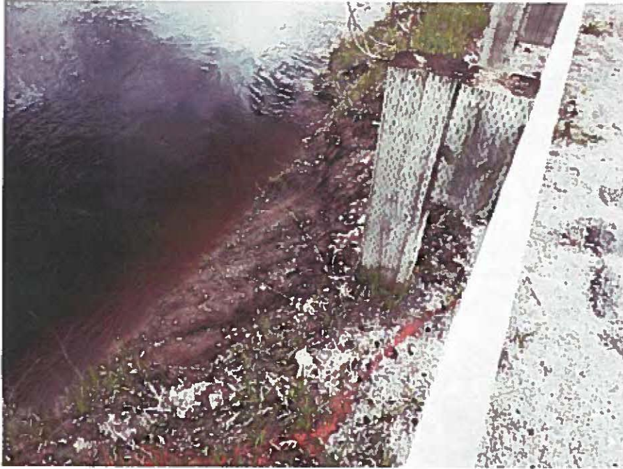
Photo 3 : photo du décrochement de 50 mètres : décrochement superficiel atteignant la glissière de sécurité
