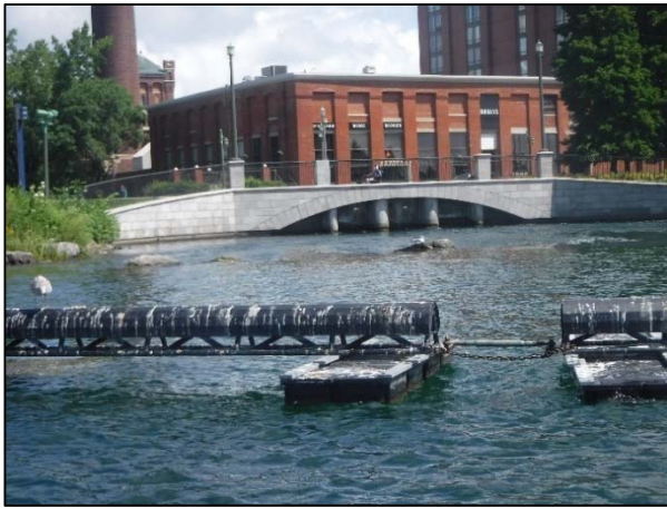
Photo 14 Vue amont du ponceau de l'avenue du Centenaire
