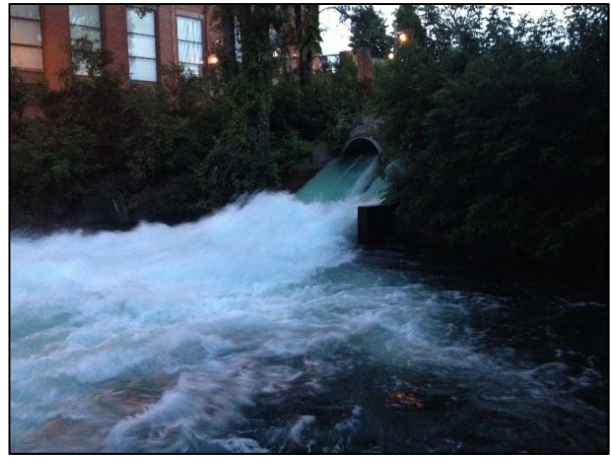
Photo 15 Vue aval du ponceau de l'avenue du Centenaire
