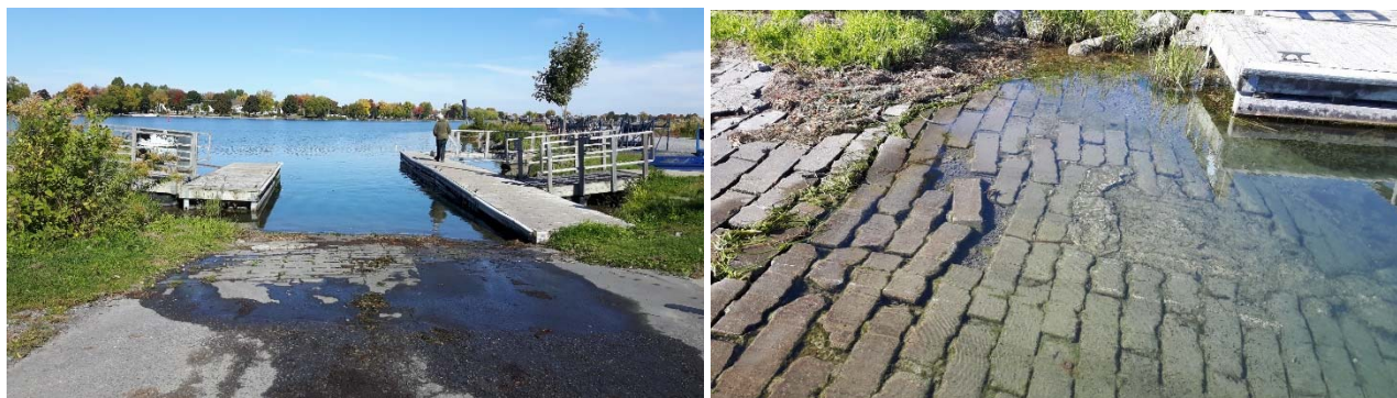
Figure 2-4 Vues de la rampe de mise à l'eau principale et son état de détérioration et de sa configuration inappropriée
