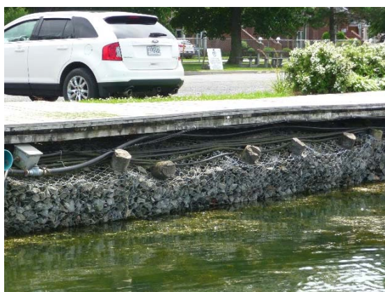
Figure 2-7 Vues de la détérioration des gabions des berges de la Marina et de l'étroitesse de la rampe de mise à l'eau dédiée
