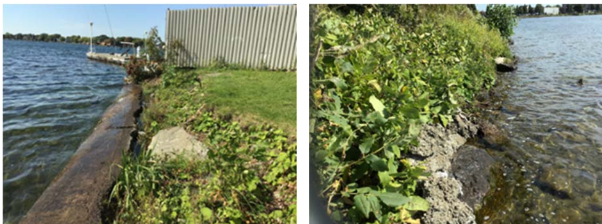
Figure 2-11 Vues du secteur de la Pointe-aux-Anglais le plus éloigné de l'avenue du Centenaire avec muret de béton qui s'affaisse et un enrochement mêlé de béton
