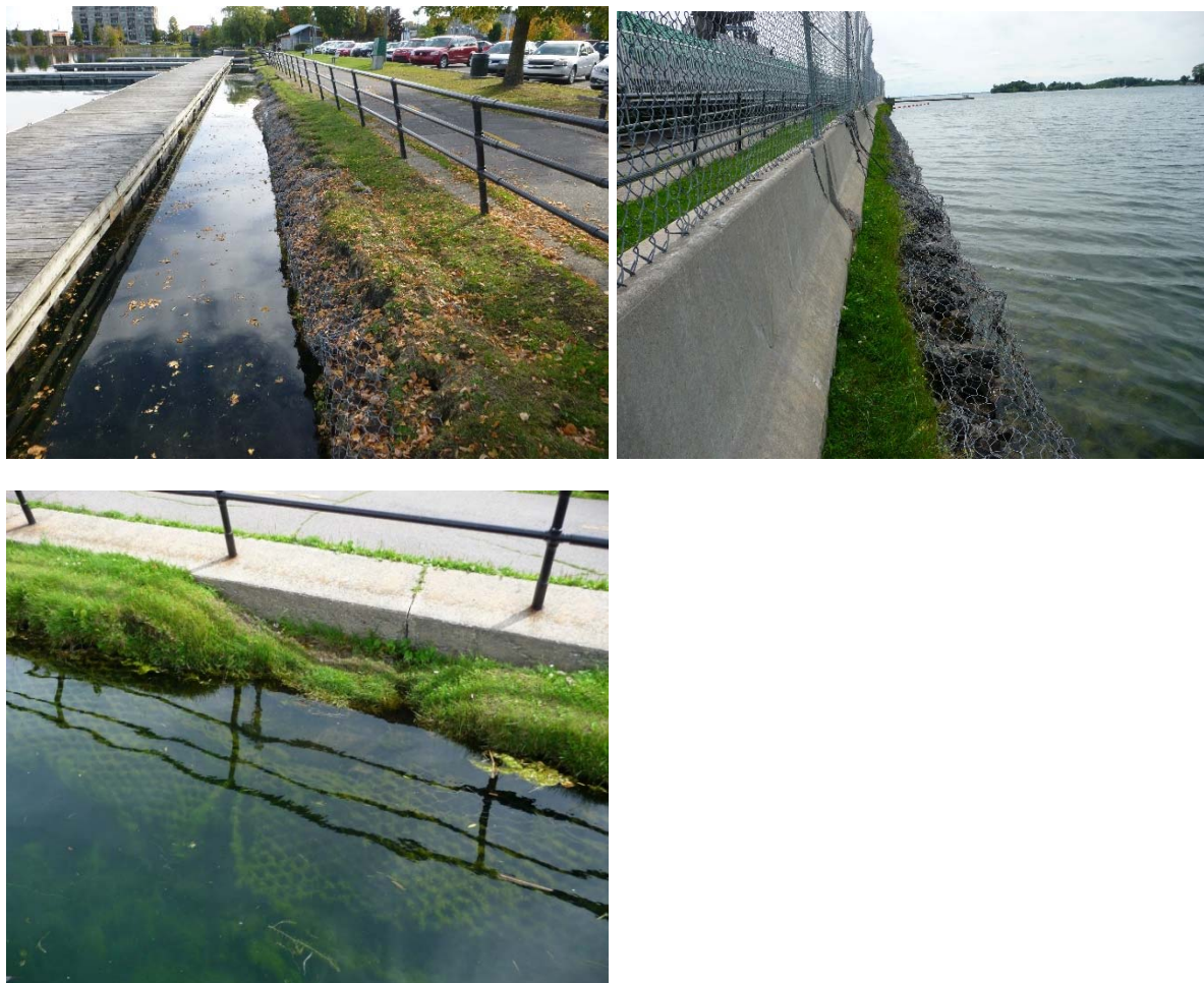
Figure 2-9 Vue des problèmes d'instabilité, d'affaissement et de détérioration des berges au parc Delpha-Sauvé dans le secteur en eau profonde (quai pour plaisanciers et quai fédéral) et dans le secteur en eau peu profonde (barrière de type New Jersey sur gabions pour assurer une protection face aux estrades lors des Régates)
