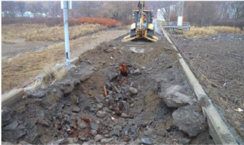
Figure 21 – Tranchée d'exploration géotechnique de la digue (Norda Stelo 2018)
