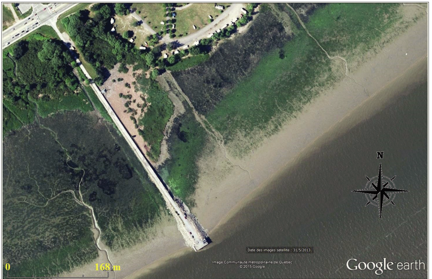
Figure 1.2 Vue aérienne du quai et de ses approches terrestres (Google™ Earth)
