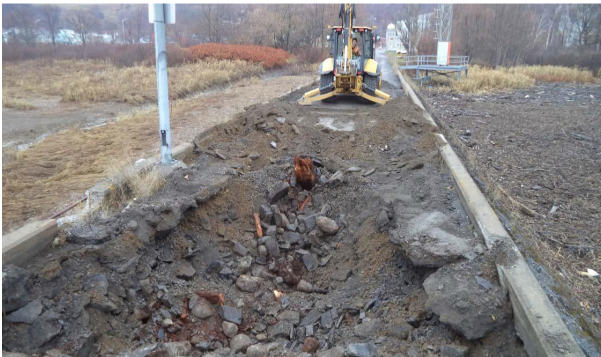
Photo 1.1 Tranchée d'exploration réalisée par SNC-Lavalin en 2016
