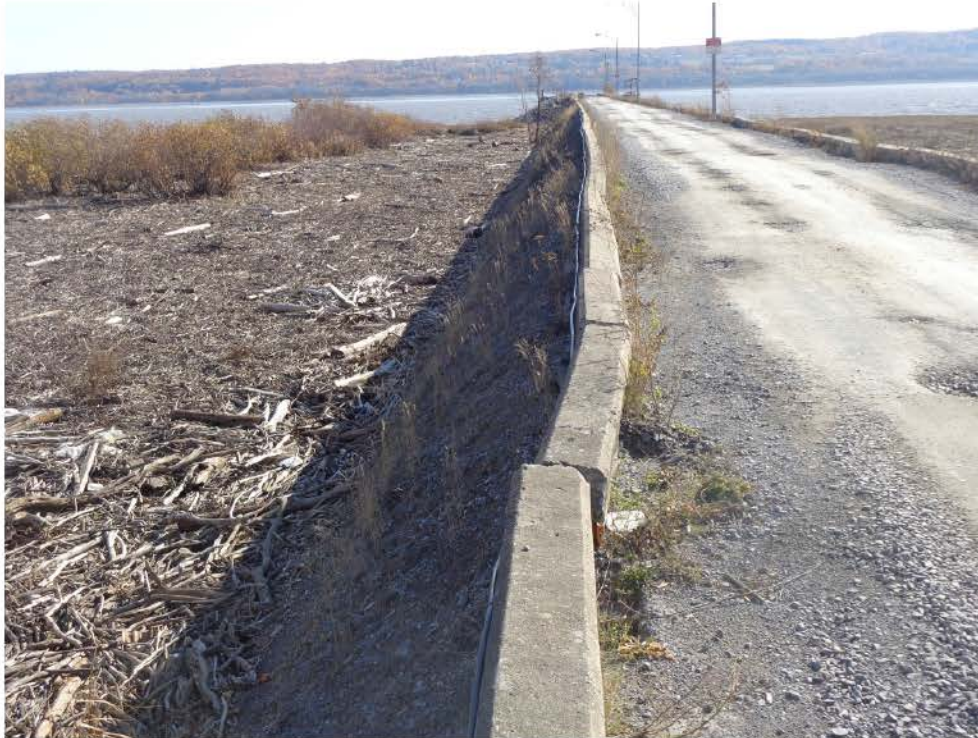
Figure 12 – Bordures de béton
