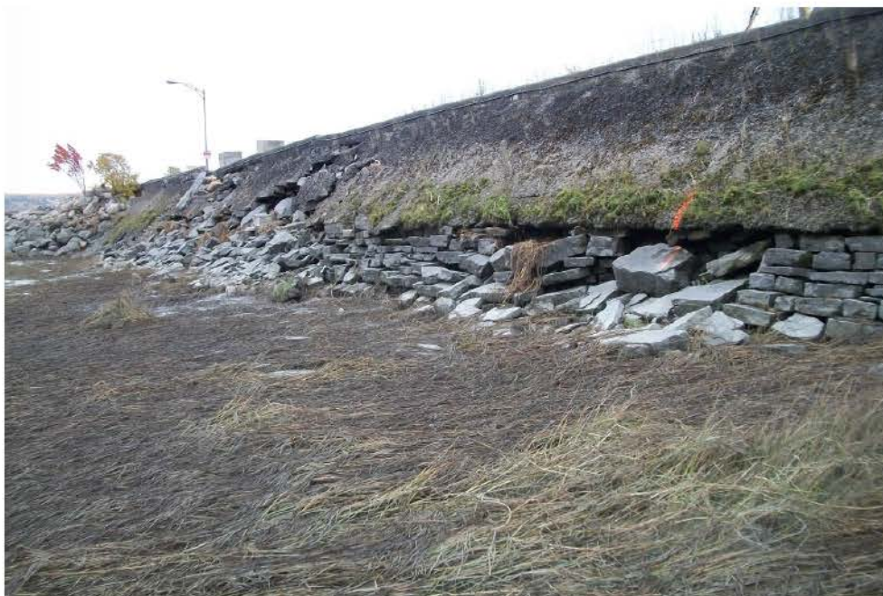
Figure 7 – Muret de pierres du côté nord de la digue (près du quai)
