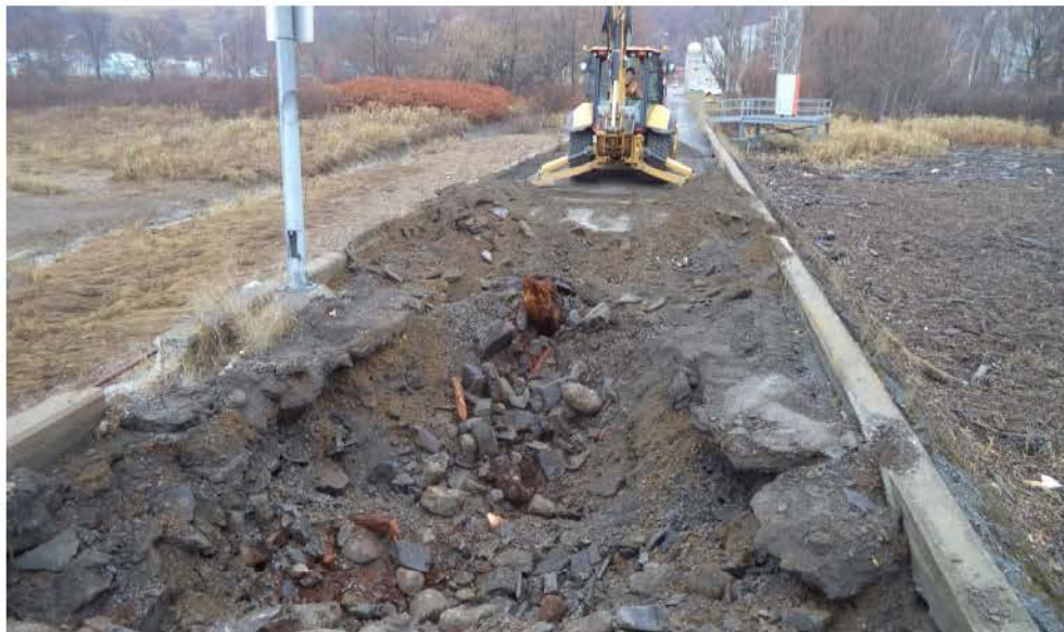
Figure 16 – Puits d'exploration de la digue
