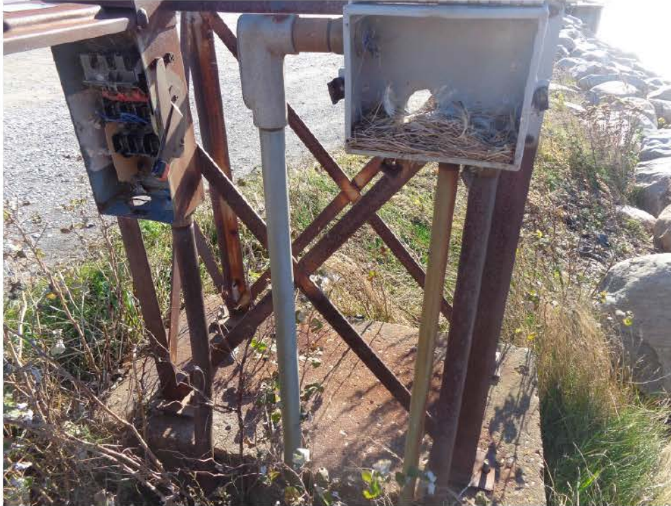
Figure 35 – Boîtes de jonction et sectionneur désaffectées
