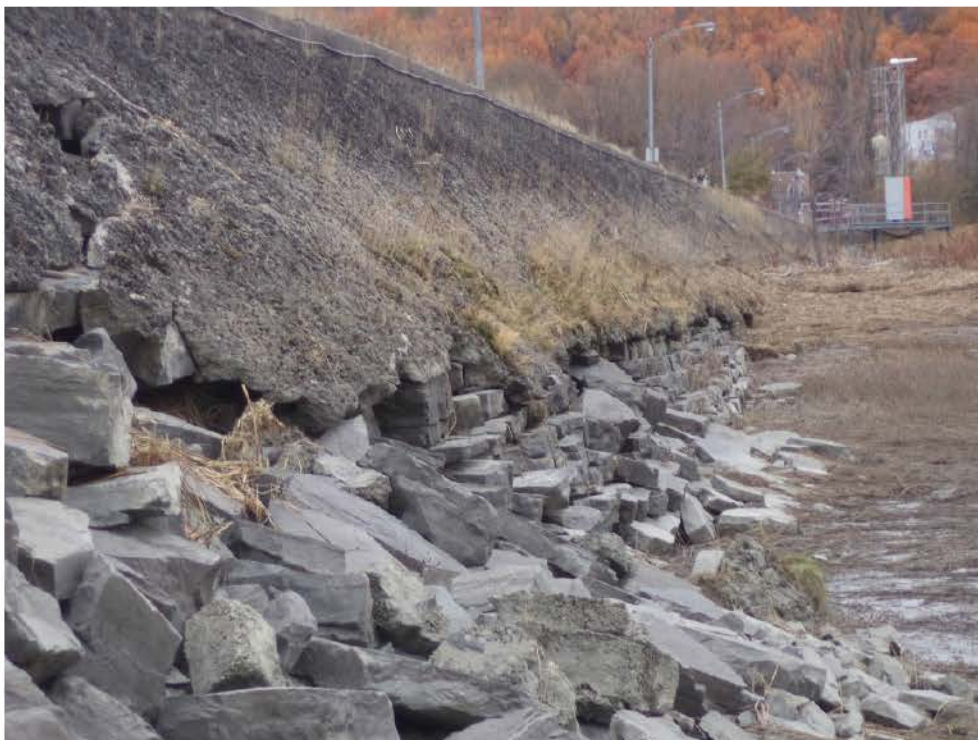
Figure 8 – Muret de pierres du côté nord de la digue (près du feu de navigation)
