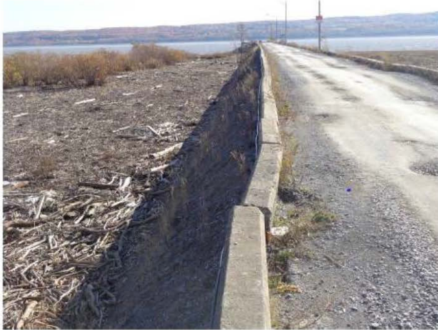
Photo 1.3 Bordure de béton de la digue (côté est) (source : SNC-Lavalin, 2016)
