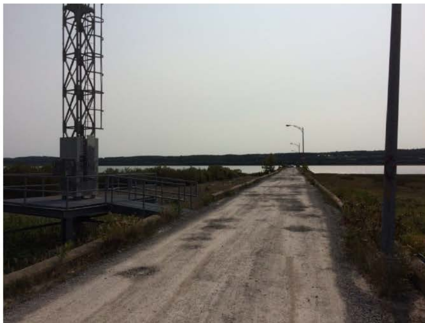
Photo 1.2 Vue générale de la digue du quai (septembre 2017)
