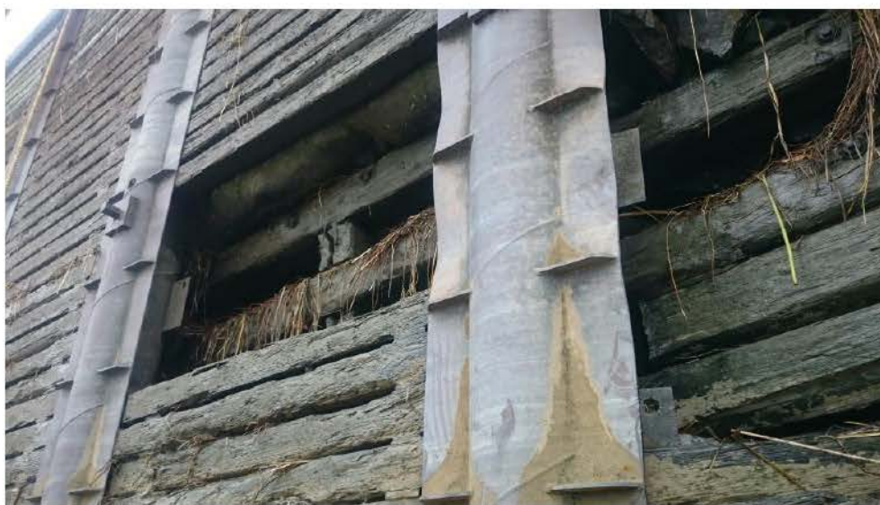
Figure 25 – Pieu 20, côté ouest
