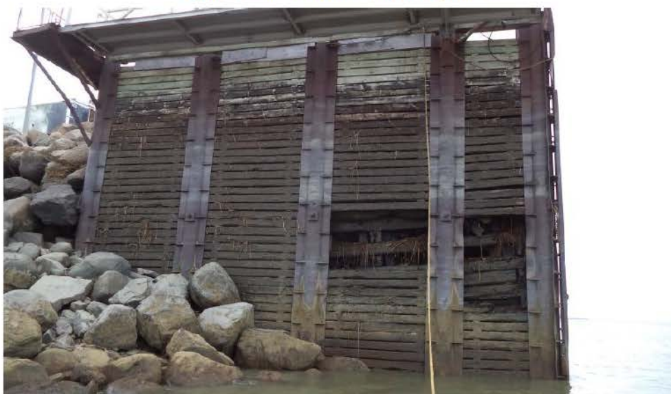
Figure 20 – Deux grandes ouvertures, côté ouest
