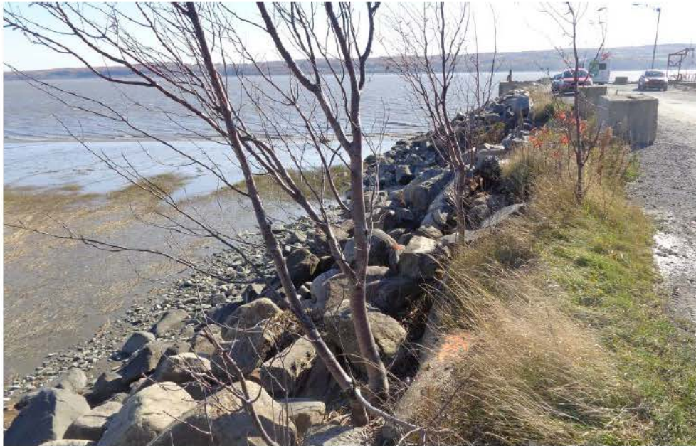
Figure 15 – Arbres en haut de talus
