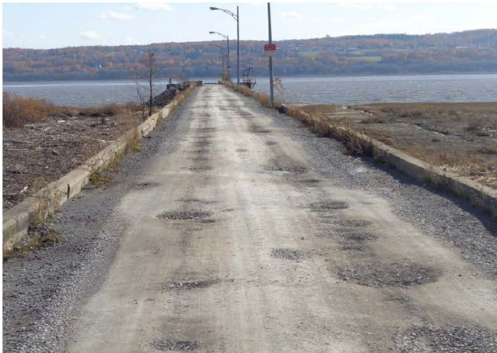
Figure 17 – État de la surface de roulement
