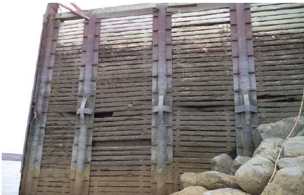
Figure 19 – Pièces de bois manquantes, côté est
