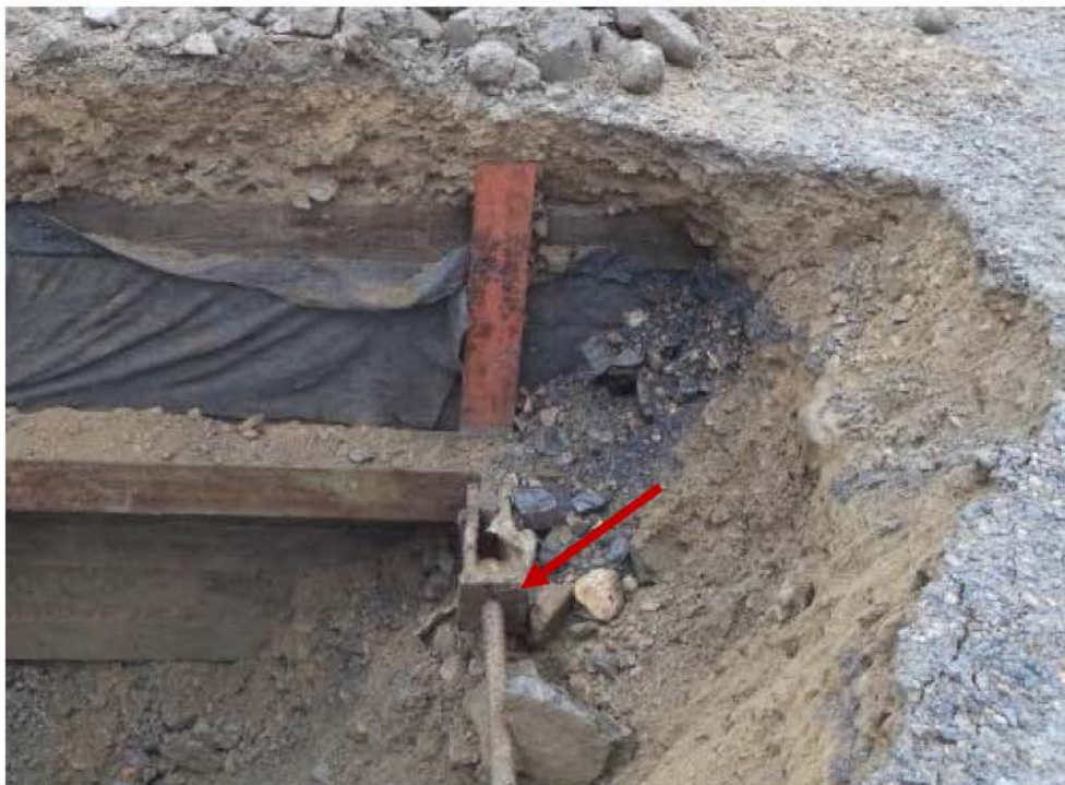
Figure 26 – Tirant servant à rattacher le pieu 20
