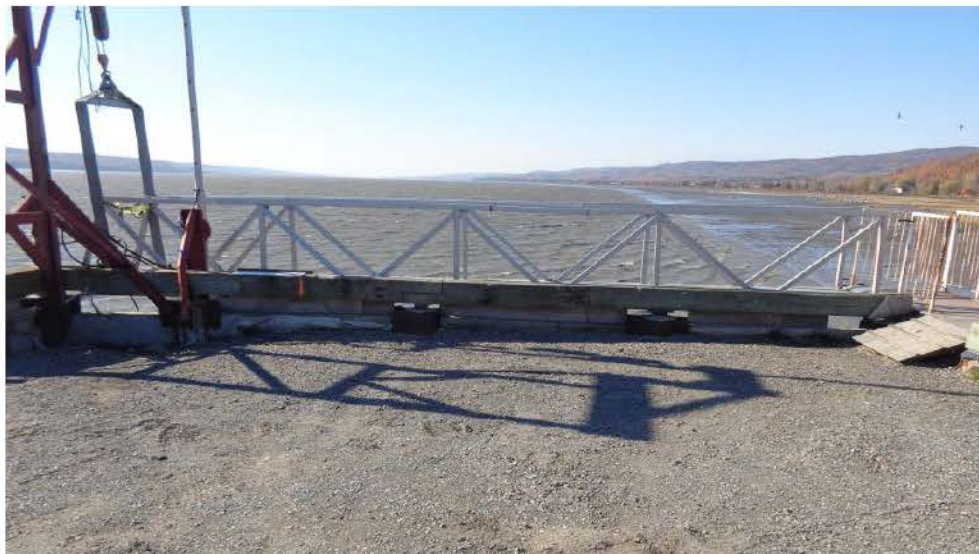
Figure 29 – Vue générale de la rampe
