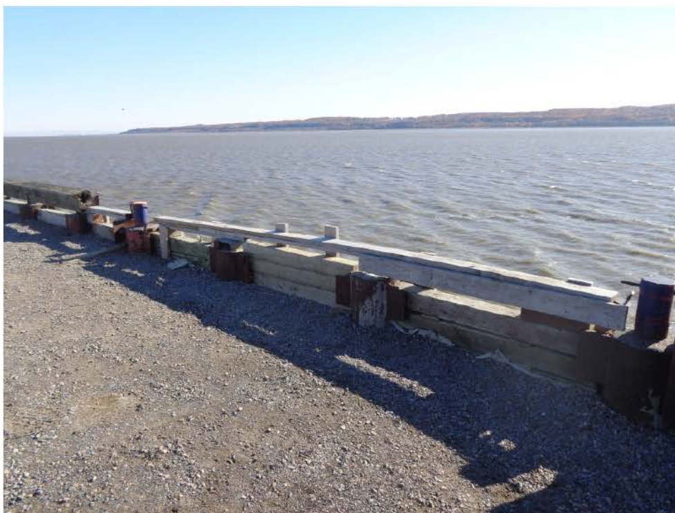
Figure 23 – Pieux du côté sud du quai
