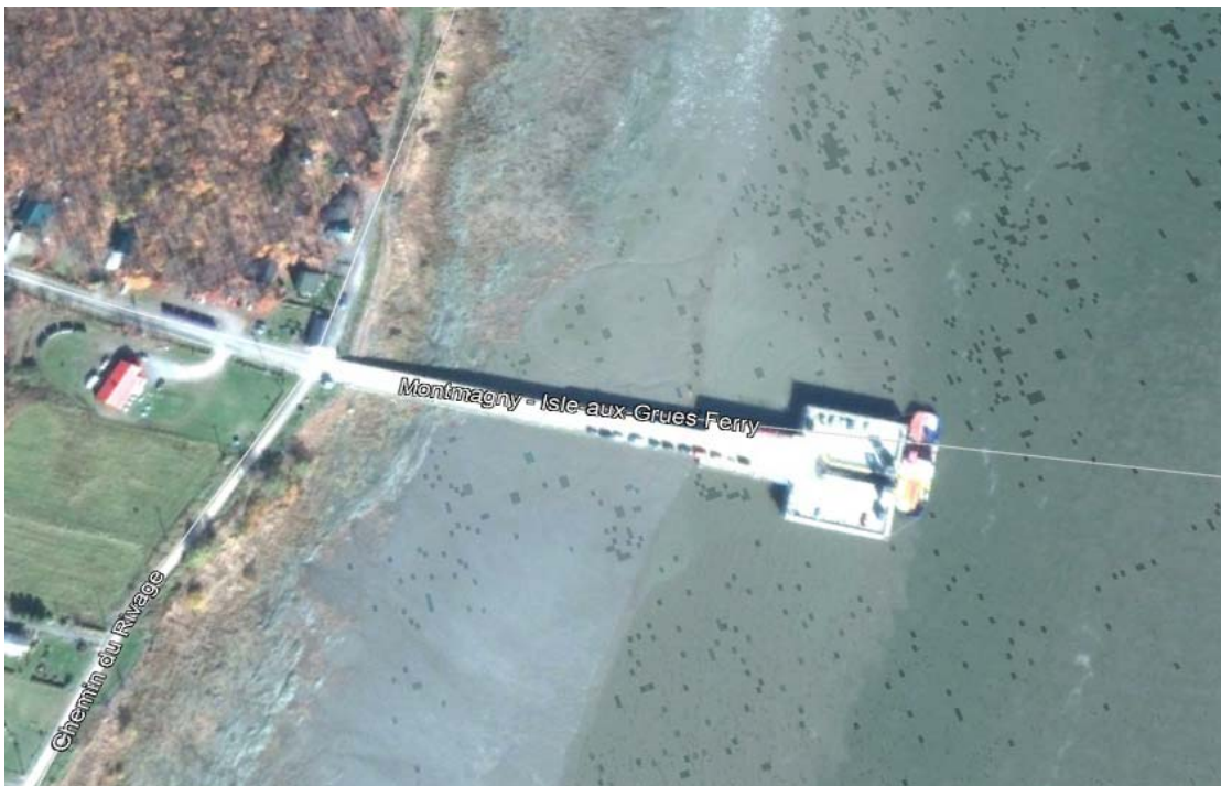
Photo 2.12 Vue aérienne du quai de l'Isle-aux-Grues en 2012 illustrant l'absence de débris à l'aval du quai
