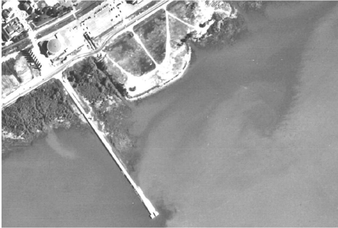
Photo 2.7 Image aérienne du quai en 1981
