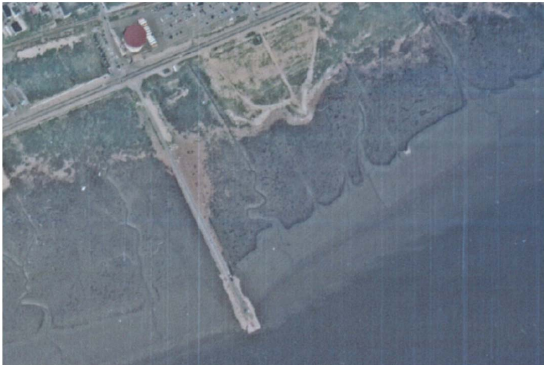
Photo 2.6 Image aérienne du quai en 1972
