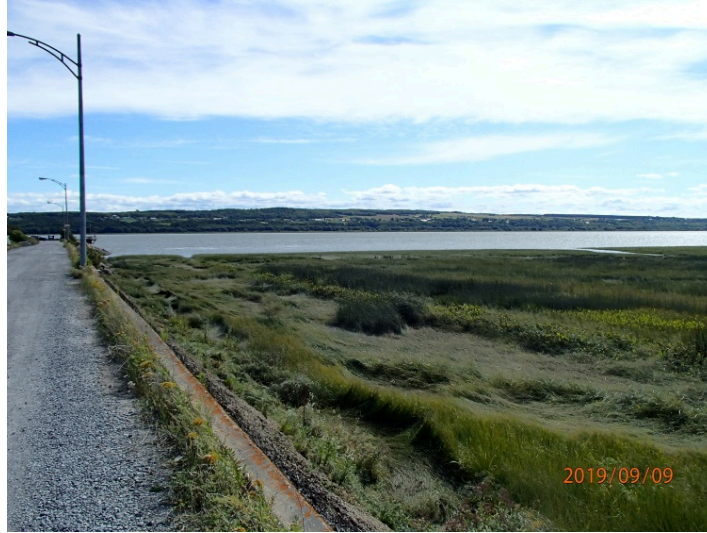
Photo 1.2 Vue vers l'aval, côté ouest
