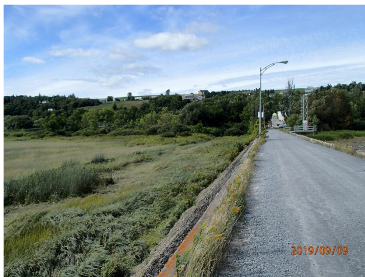
Photo 1.1 Vue vers l'amont, côté ouest
