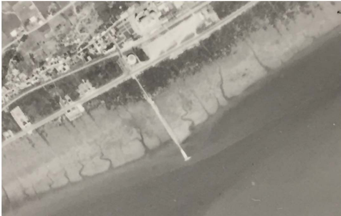
Photo 2.5 Image aérienne du quai en 1952
