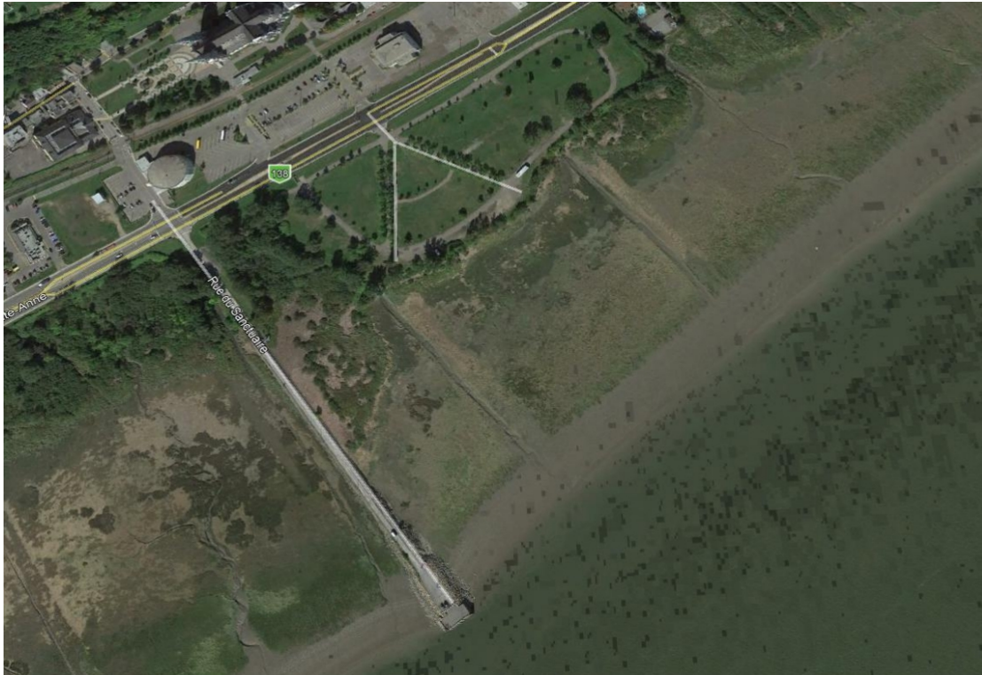
Photo 2.11 Image aérienne du quai en 2018
