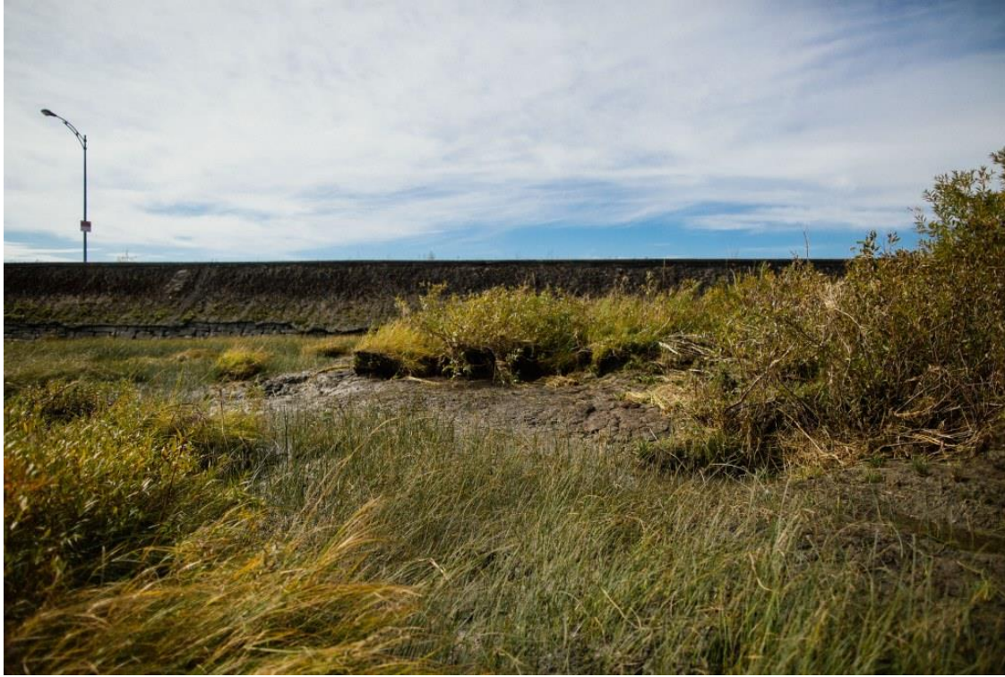
Photo 2.1 Vue vers l'amont de la limite inférieure de la zone à aménager
