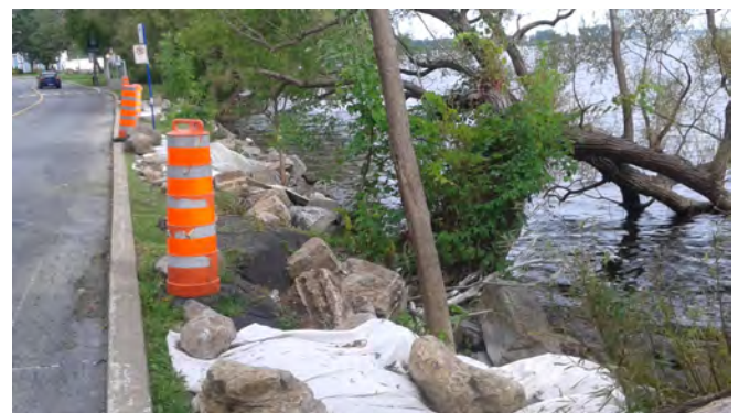
Photo 4 : Segment 42 – Travaux de stabilisation d'urgence (photo prise le 6 mai 2017).
