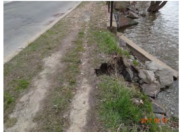
Photo 8 : Segment 51 – Effondrement de la berge à moins de 2 m du chemin du Bord-du-Lac-Lakeshore (photo prise le 10 mai 2017).
