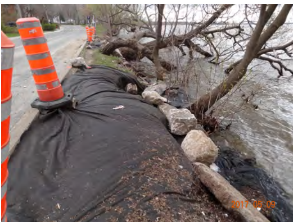
Photo 5 : Segment 42 – Travaux de stabilisation d'urgence (photo prise le 9 mai 2017).
