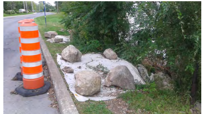
Photo 8 : Segment 51 – Effondrement de la berge à moins de 2 m du chemin du Bord-du-Lac-Lakeshore (photo prise le 10 mai 2017).
