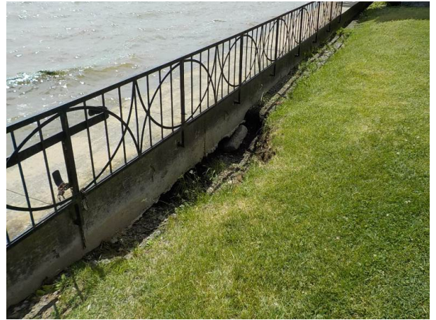
Photo 38 : Effondrement à la tête du mur (segment 25).
