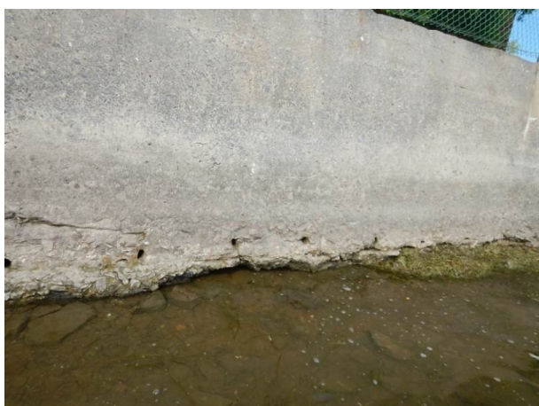
Photo 11 : Affouillement et désagrégation du béton (segment 4A).
