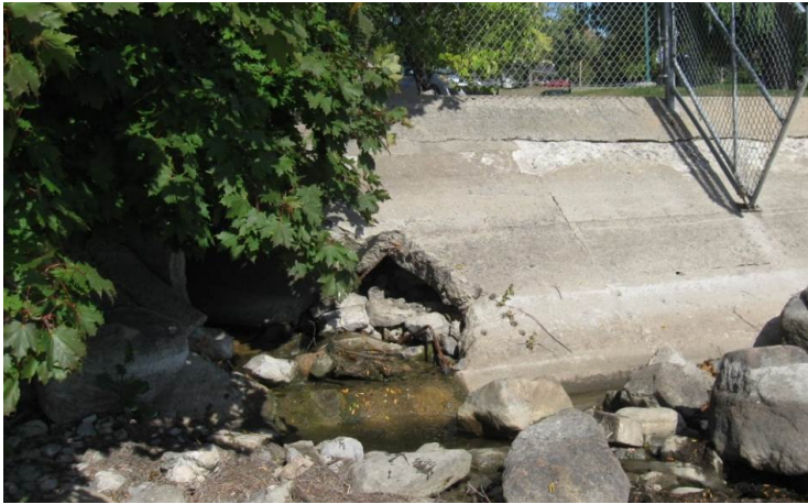
Photo 37 : Perforation à la base du mur (segment 25).
