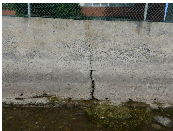
Photo 12 : Fissuration et décalage horizontal de 8 mm par rapport à la fissure (segment 4A).
