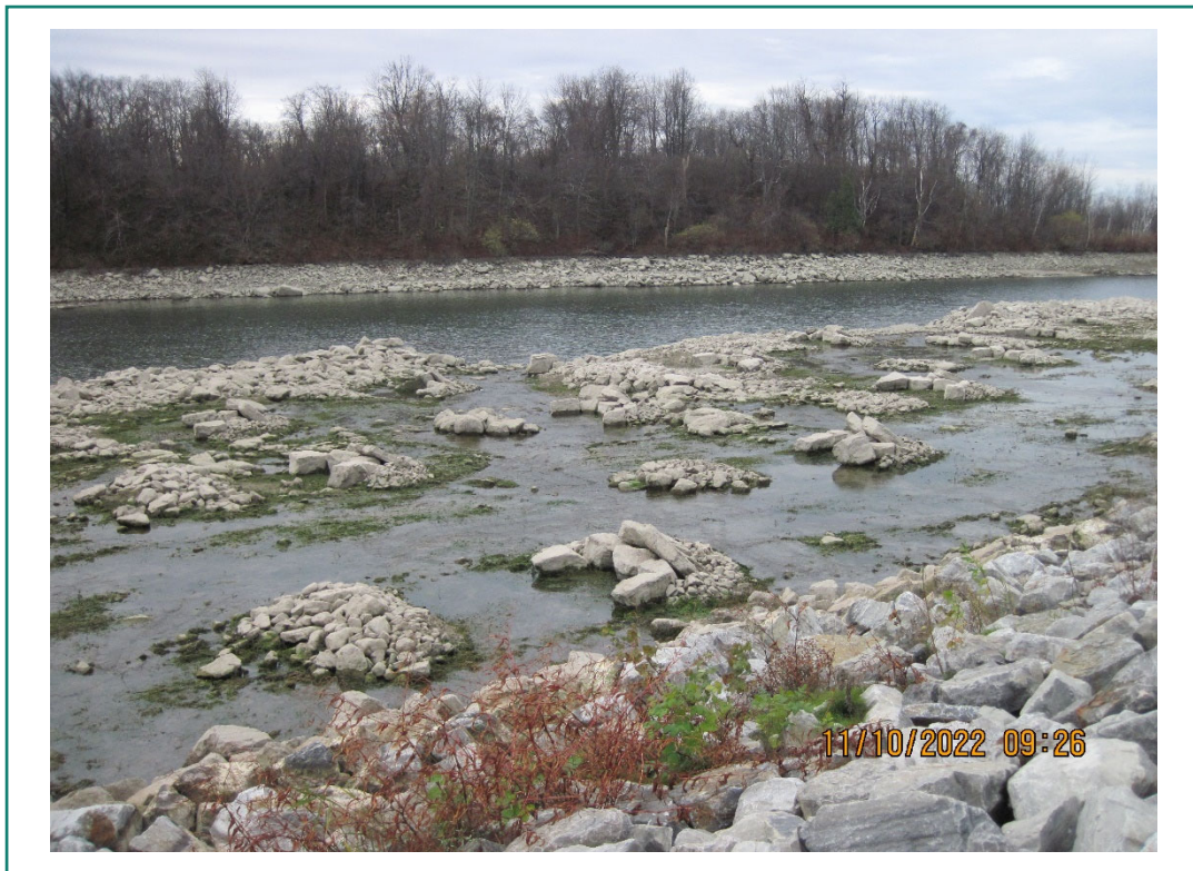
Photo 7 : Zone d'écoulement provenant de la digue sur la frayère de la portion aval du filtre inverse amont dans le bassin de Saint-Timothée durant l'automne 2022
