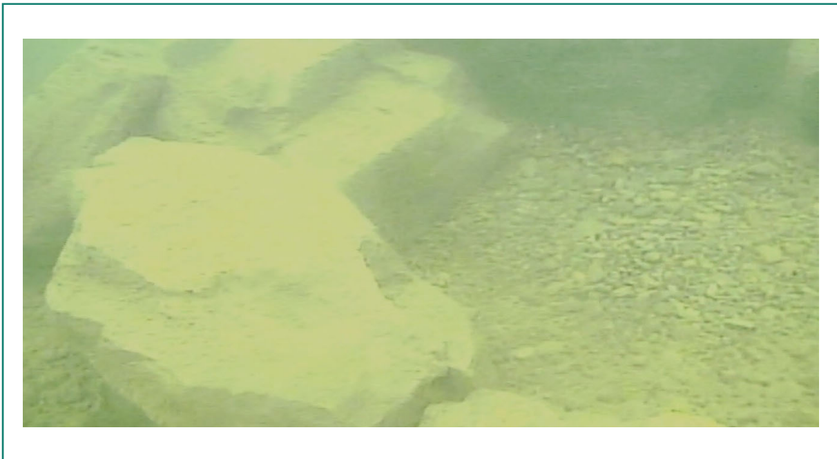
Photo 8 : Vue sous-marine du nid 8 sur la frayère aménagée en bordure de la portion amont du filtre inverse amont dans le bassin de St-Timothée au cours de l'été 2022
