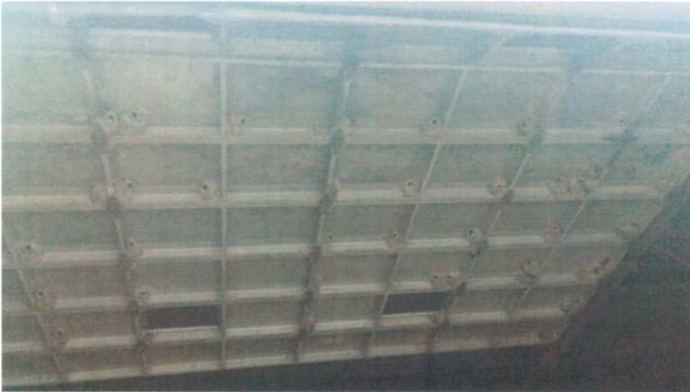
Fig. 7. Nids d’Hirondelles à front blanc dans la porte de garage sur le quai.
