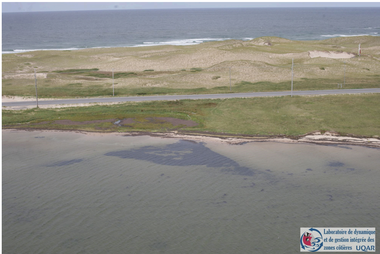
Figure 4-10 : Vue générale de la route 199 entre les chaînages 5+000 et 5+400
