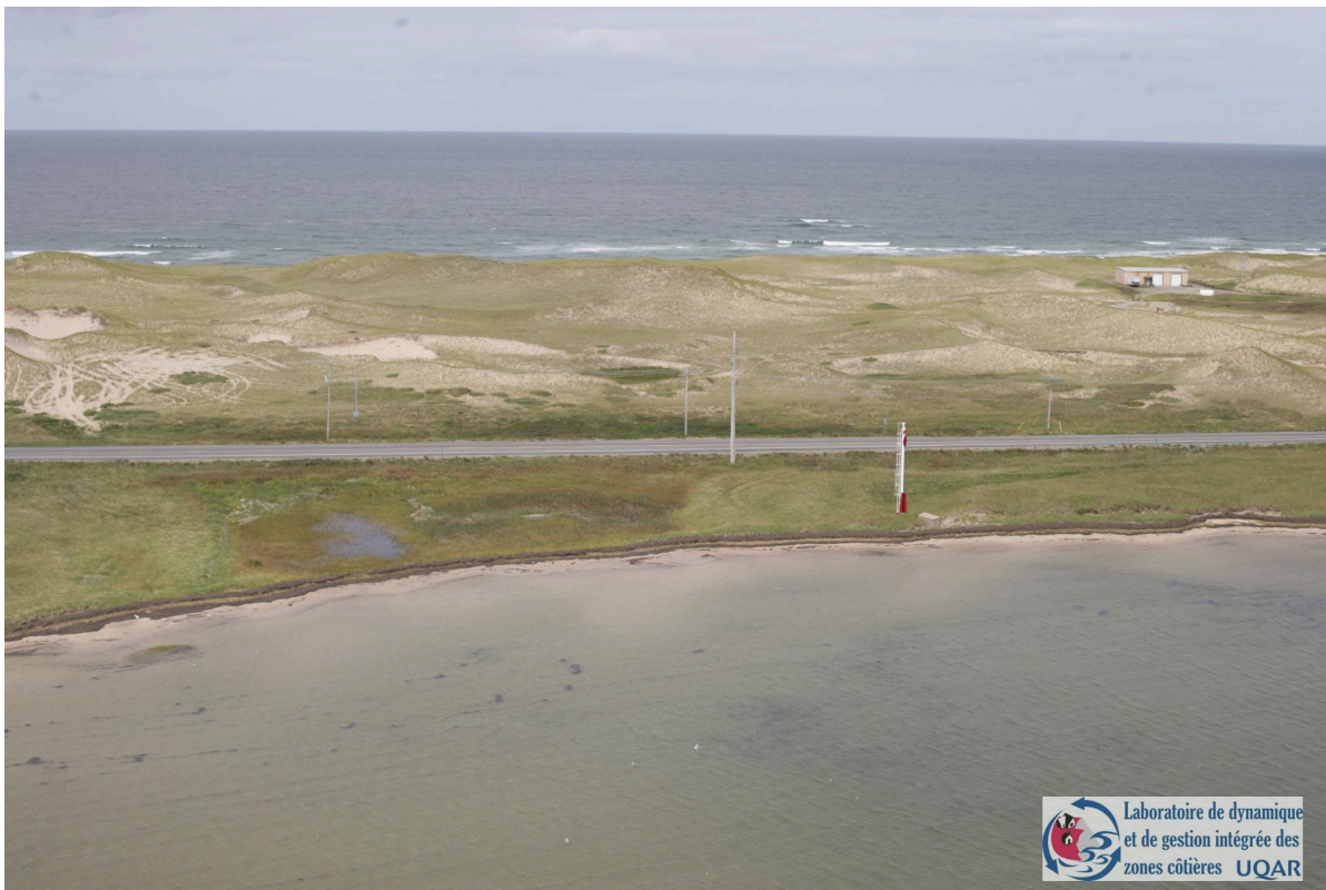
Figure 4-9 : Vue générale de la route 199 entre les chaînages 5+400 et 5+900
