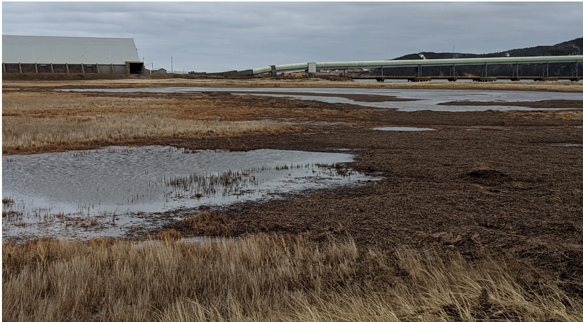
Figure 4-8 : Vue du marais et des installations à proximité du quai de Windsor
