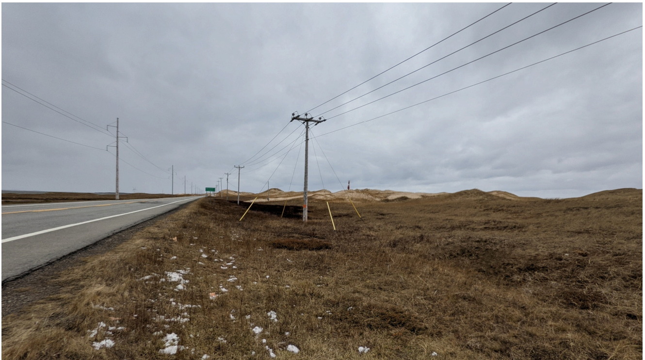
Figure 4-5 : Dégagement latéral côté nord de la route 199 (chaînage 5+550 m)
