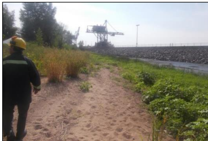
Photo 97 Avant les travaux. (02/08/2012)
