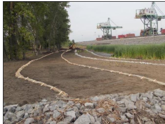
Photo 80 Après les travaux. (17/08/2012)
