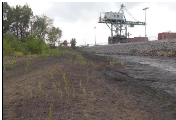
Photo 98 Après les travaux. (17/08/2012)
