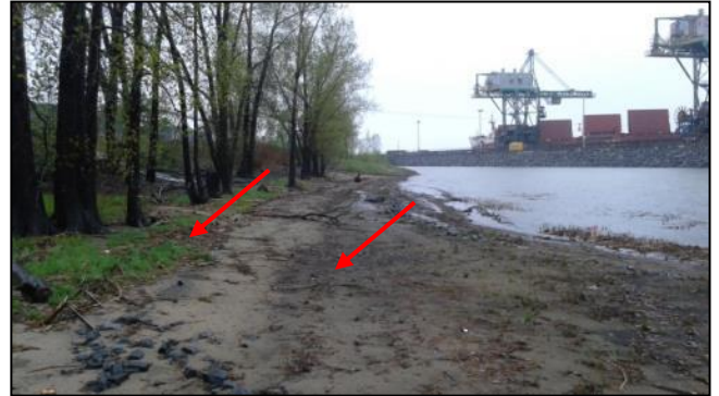
Photo 6 Emplacement des rangées de fagots qui sont partiellement ou entièrement ensevelies entre les piquets 5 et 6. (11/05/2015)
