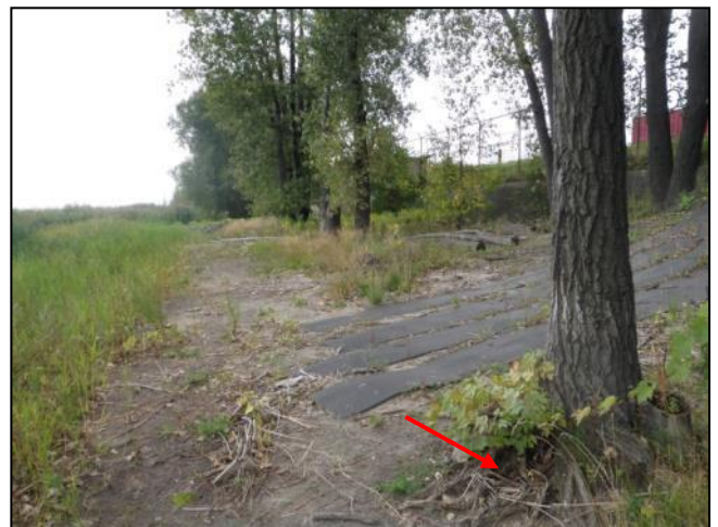
Photo 38 Les racines d'un seul arbre étaient à découvert dans le secteur de la descente. (25/09/2015)
