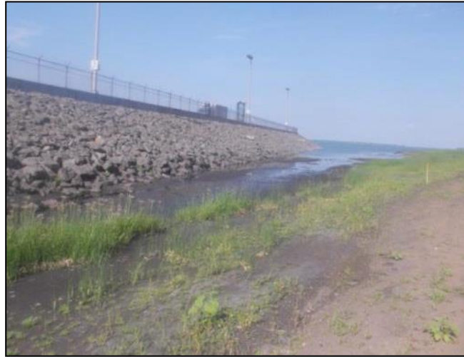
Photo 91 Avant les travaux. (02/08/2012)
