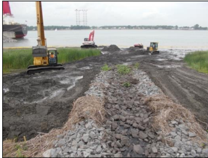
Photo 73 Pendant les travaux. (13/08/2012)
