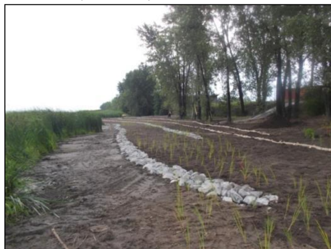
Photo 86 Après les travaux. (17/08/2012)
