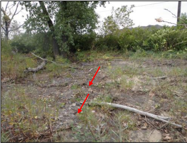
Photo 39 Signes de ruissellement dans le haut de la plage entre les piquets 4 et 5. (25/09/2015)
