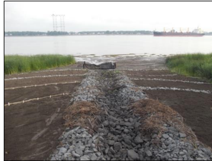
Photo 74 Après les travaux. (17/08/2012)
