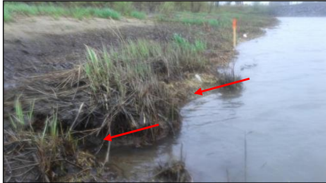
Photo 5 Signes d'érosion mineurs (piquet 3) démontrant l'effet stabilisant du système racinaire des plantes. (11/05/2015)
