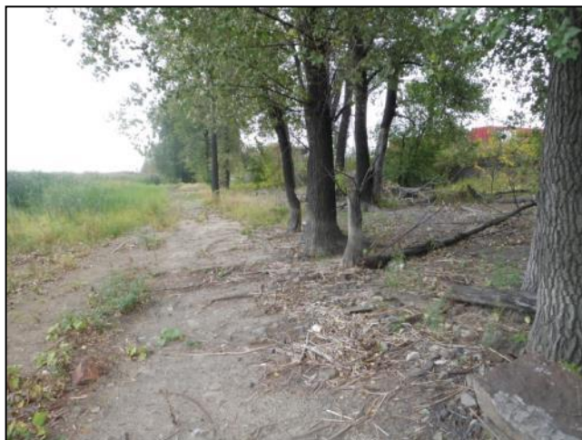
Photo 37 Racines des arbres matures entre les piquets 5 et 6. (25/09/2015)
