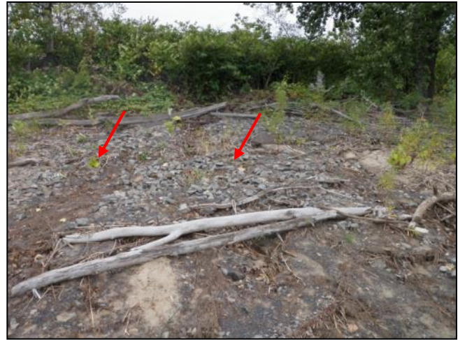
Photo 40 Signes de ruissellement dans le haut de la plage entre les piquets 4 et 5. (25/09/2015)
