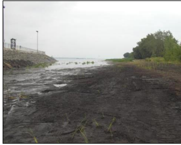
Photo 92 Après les travaux. (17/08/2012)
