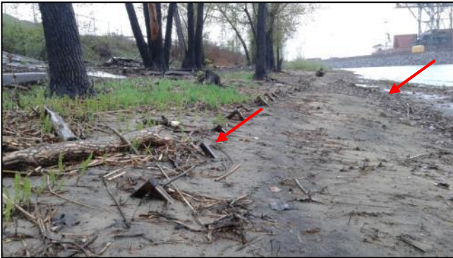
Photo 29 Deux rangées de fagots ensevelies du côté ouest du stormceptor (piquets 5 et 6). (11/05/2015)
