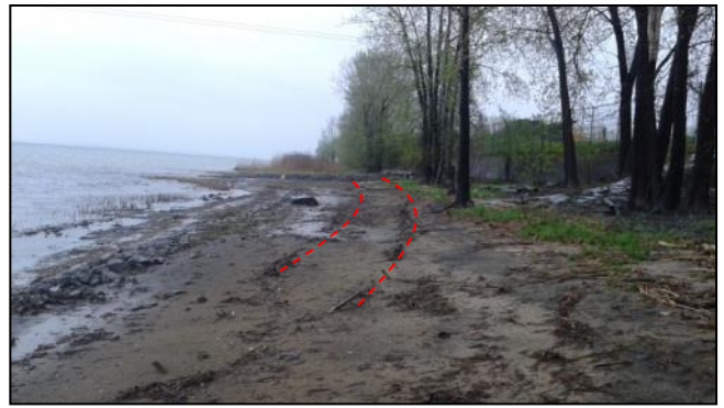
Photo 28 Deux rangées de fagots ensevelies du côté ouest du stormceptor (piquets 5 et 6). (11/05/2015)
