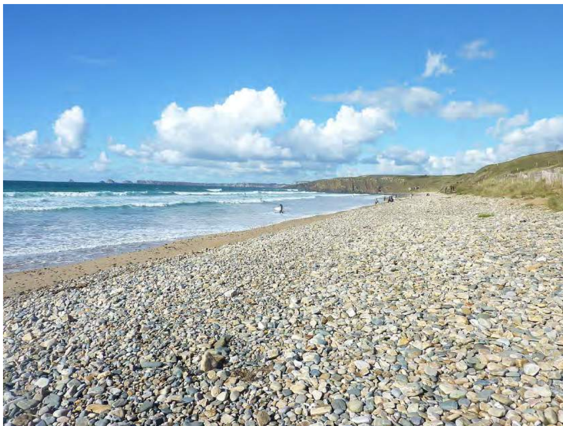
Figure 4-8 Exemple de recharge de plage à l'aide de matériaux plus grossiers de type cailloux/galets pour l'aménagement de la variante 2 (V2)
