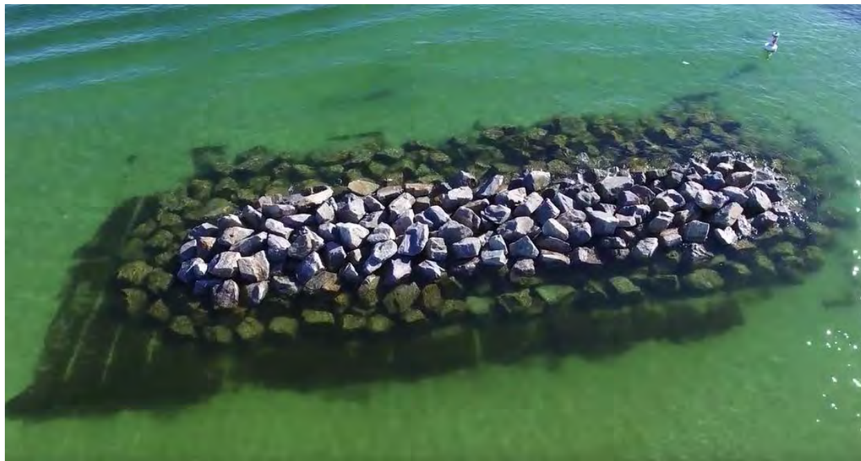
Figure 4-11 Exemple de brise-lames typique en enrochement (V3B)
