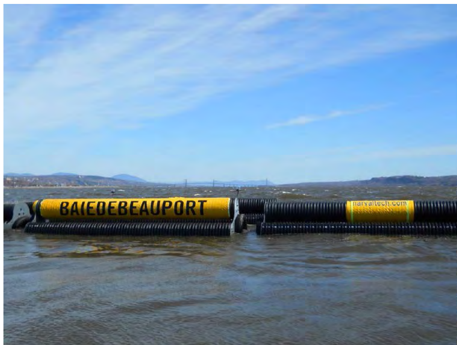
Figure 4-13 Exemple de brise-lames flottant de marque Narval
