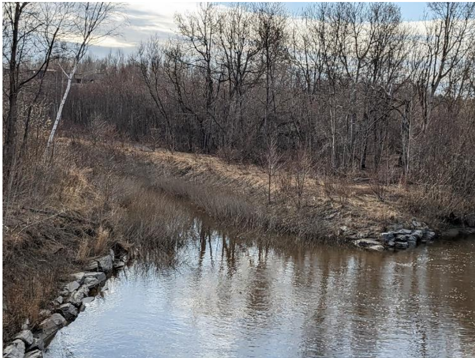
Figure 6. État d'envoieement du canal piscicole le 21 avril 2023 ( 122,6 \text{ m}^3/\text{s} )
