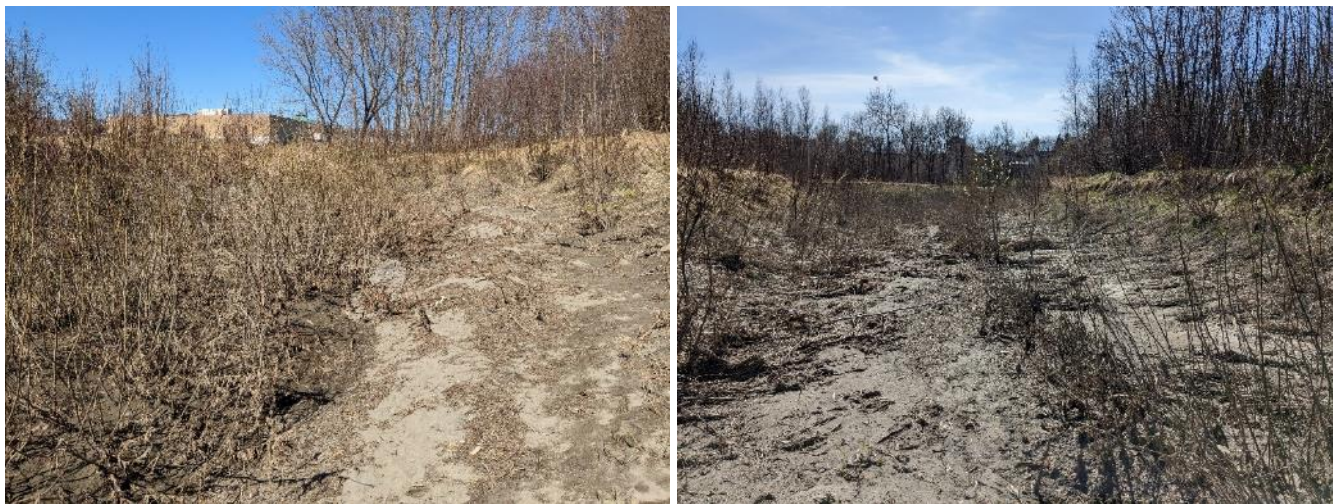
Figure 18. Accumulation de sédiments en amont du canal (28 avril 2023)
