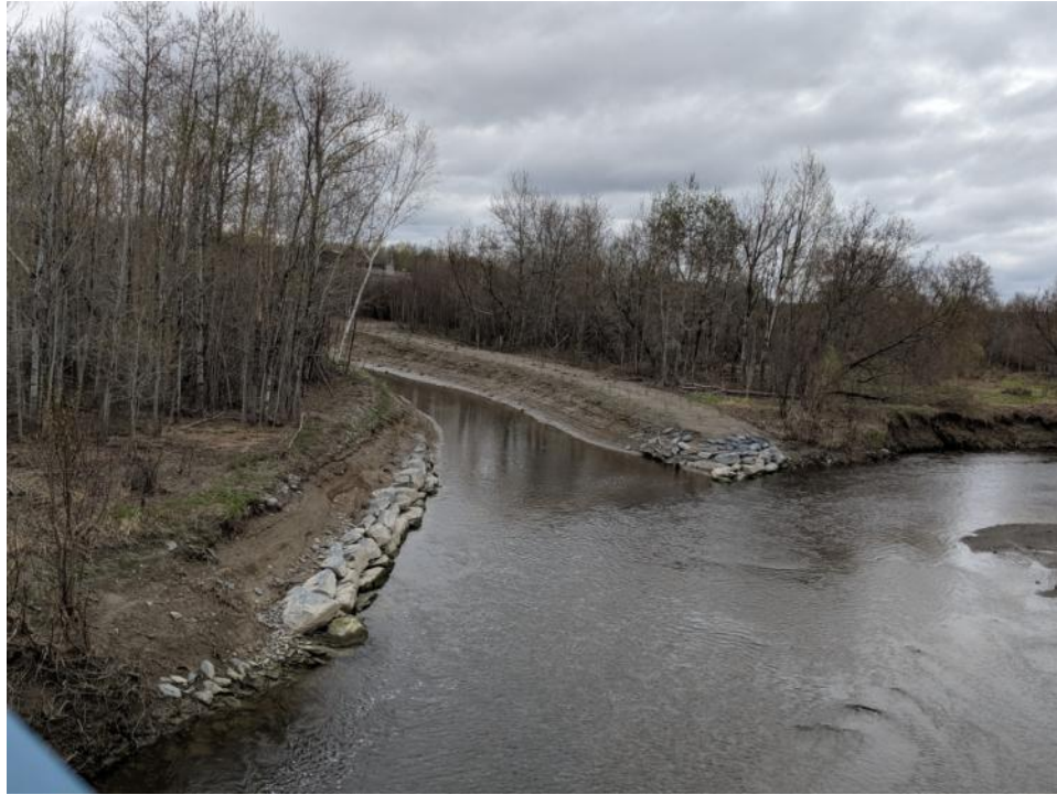
Figure 2. État d'envolement du canal piscicole le 16 mai 2019
