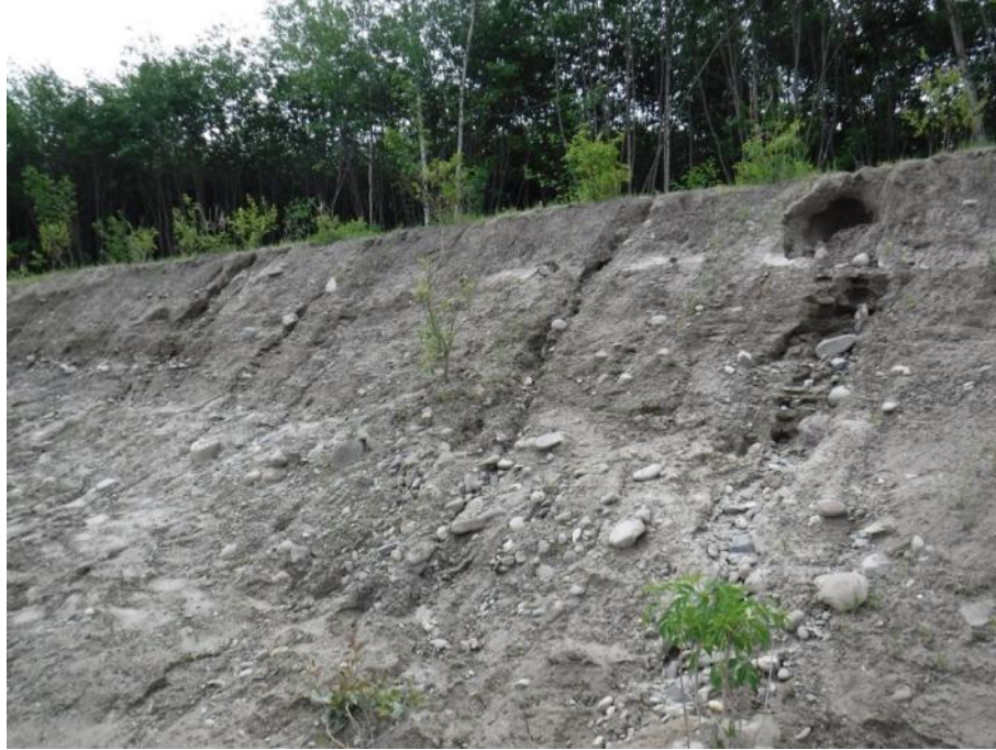
Figure 6. Érosion par ruissellement, secteur C.
