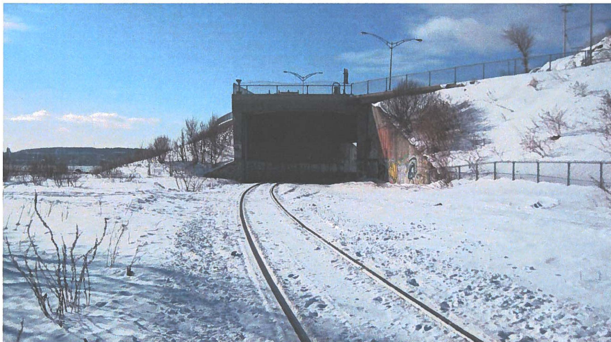
Photo 13 Tunnel ferroviaire (section 3). Vue vers le sud.
