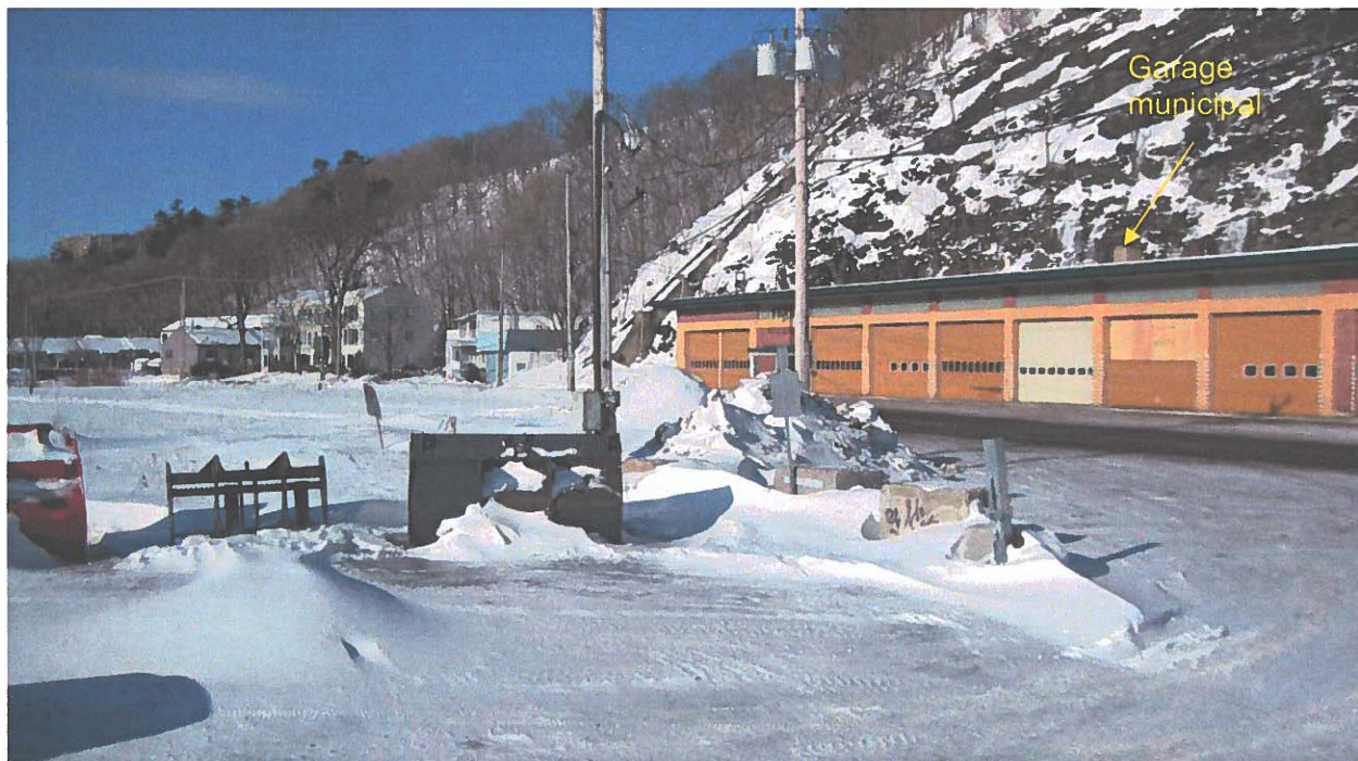
Photo 10b Garage municipal (face à la section 1). Vue vers le nord-ouest.
