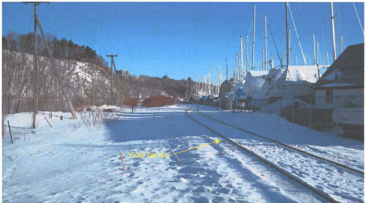
Photo 7c Ancien dépôt de Esso (section 4). Vue vers le nord-est.
