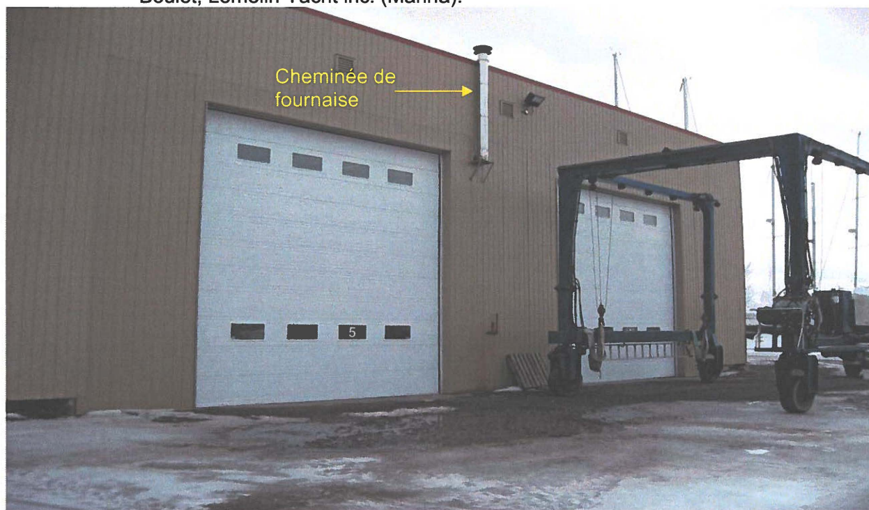
Photo 2b Portes 4 et 5, section d'entreposage, Boulet, Lemelin Yacht inc. (Marina). Vue vers le nord-est.
