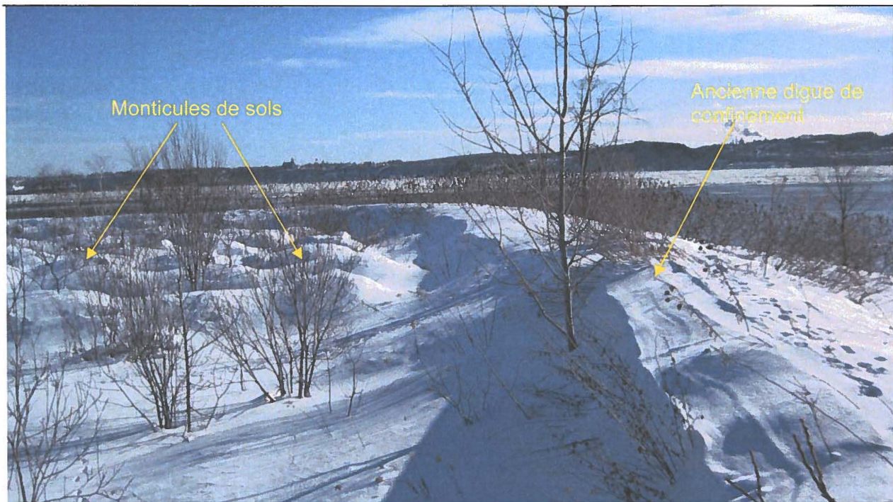
Photo 14 Prolongement de la section 3 avec digue de confinement (terrains de Shell). Vue vers l'est.
