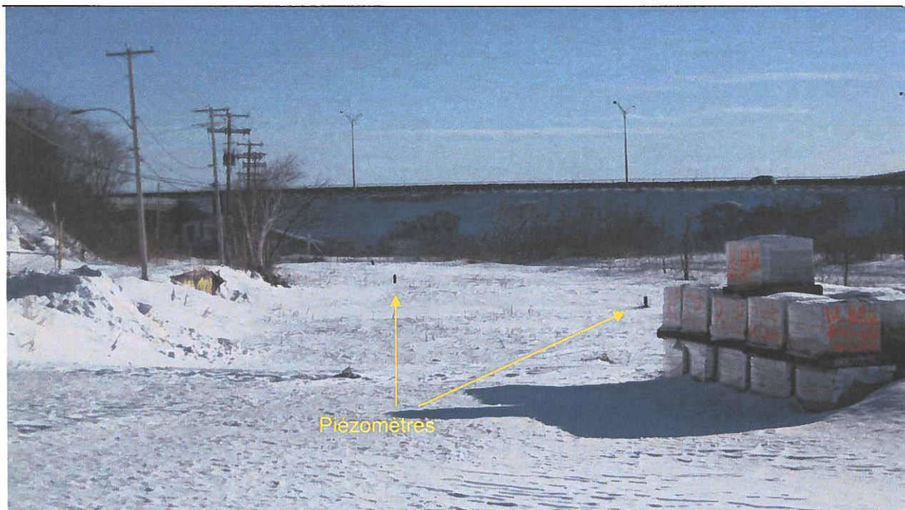
Photo 10c Ancien dépôt pétrolier de Pétro-Canada (section1). Vue vers le sud-est.
