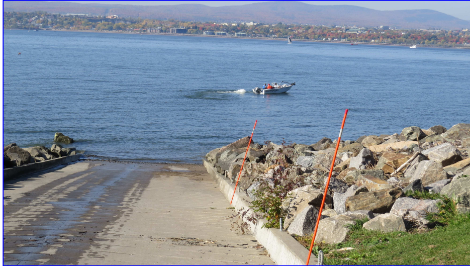
Photo 3: Rampe de mise à l'eau de la Grève Jolliet à Lévis accessible gratuitement et à marée basse
