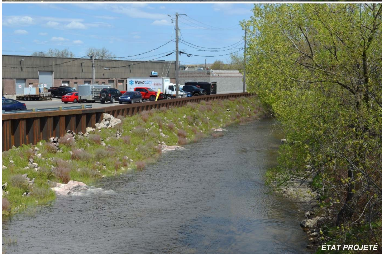
Figure 5.3 Simulation visuelle - Murs en palplanches (PK 2+720, rive gauche)
