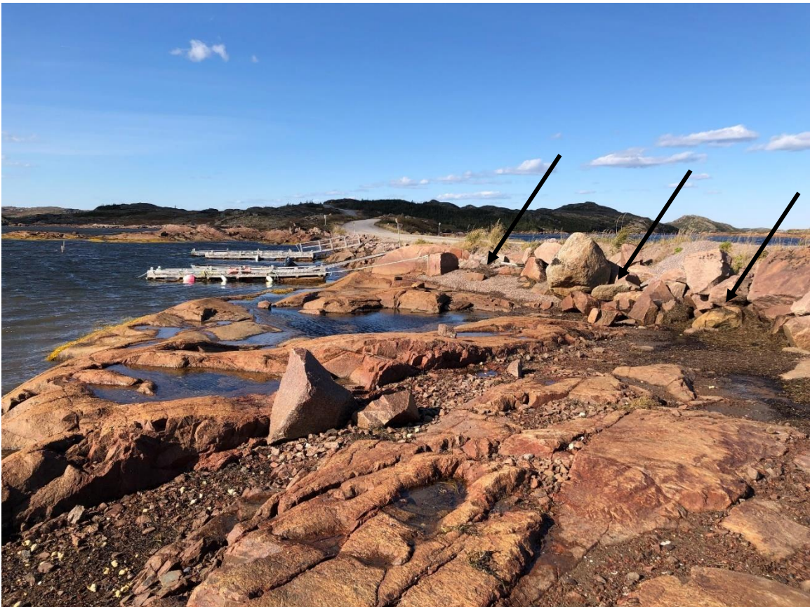
Photo 2. Ligne supérieure de débit et coloration de la pierre du talus dans le tronçon 2
