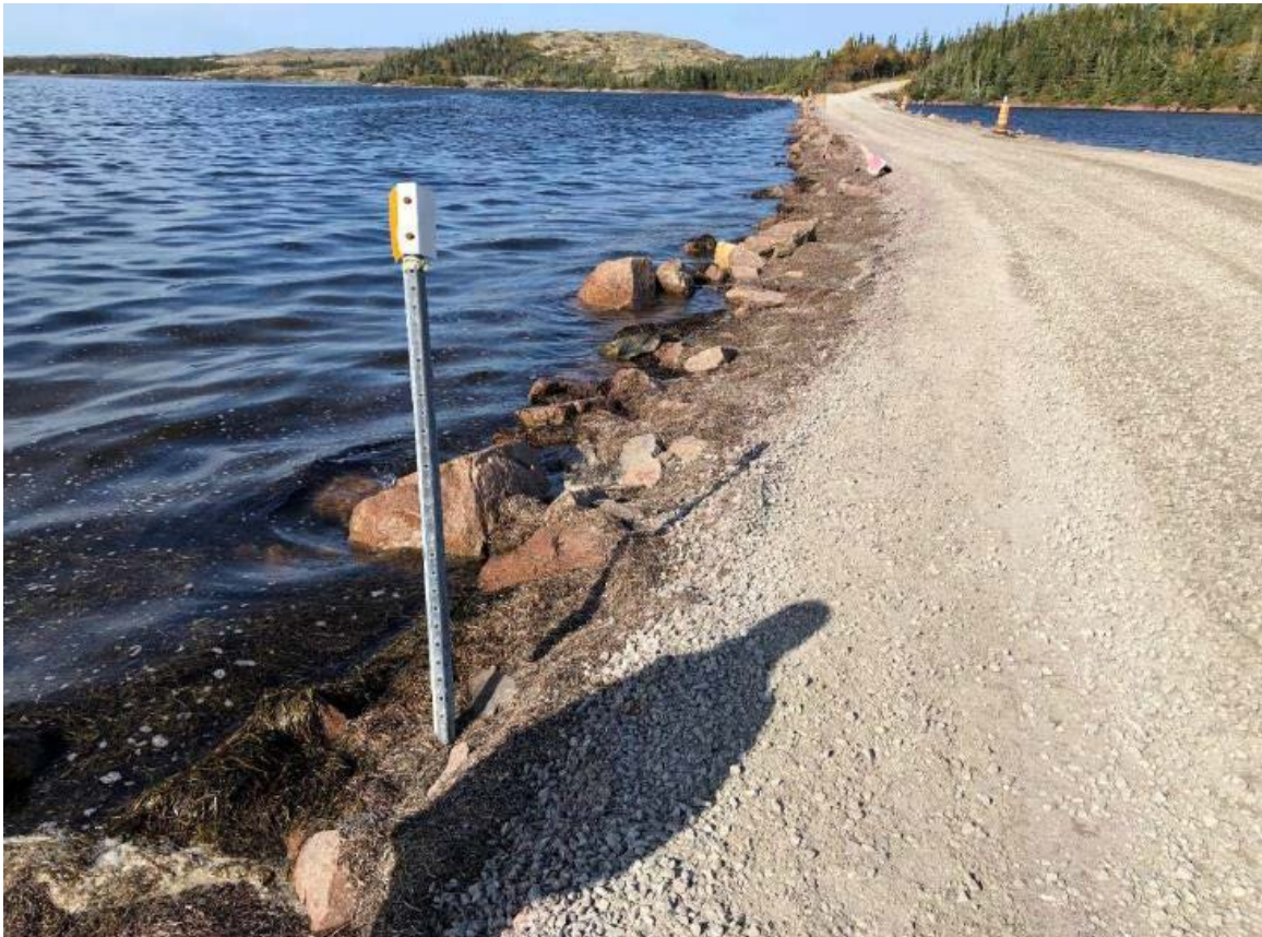
Photo 2. Vue de la chaussée qui constitue les rives, dans le cadre du projet
