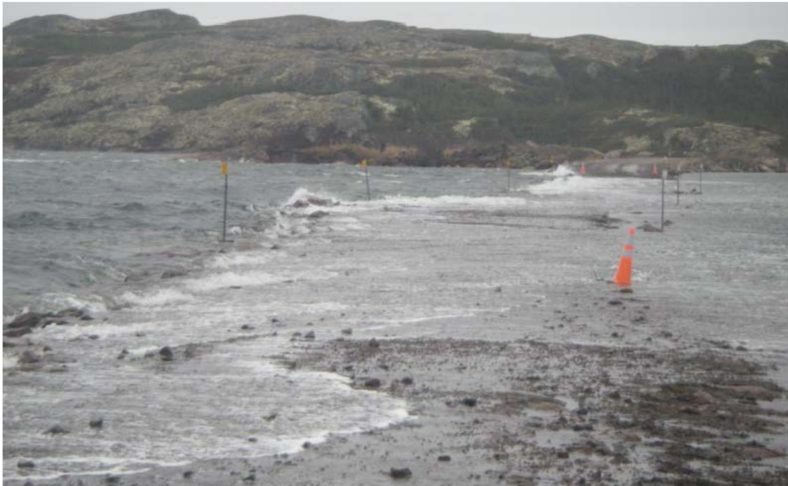
Photo 3. Tempête provoquant une submersion importante de la chaussée
