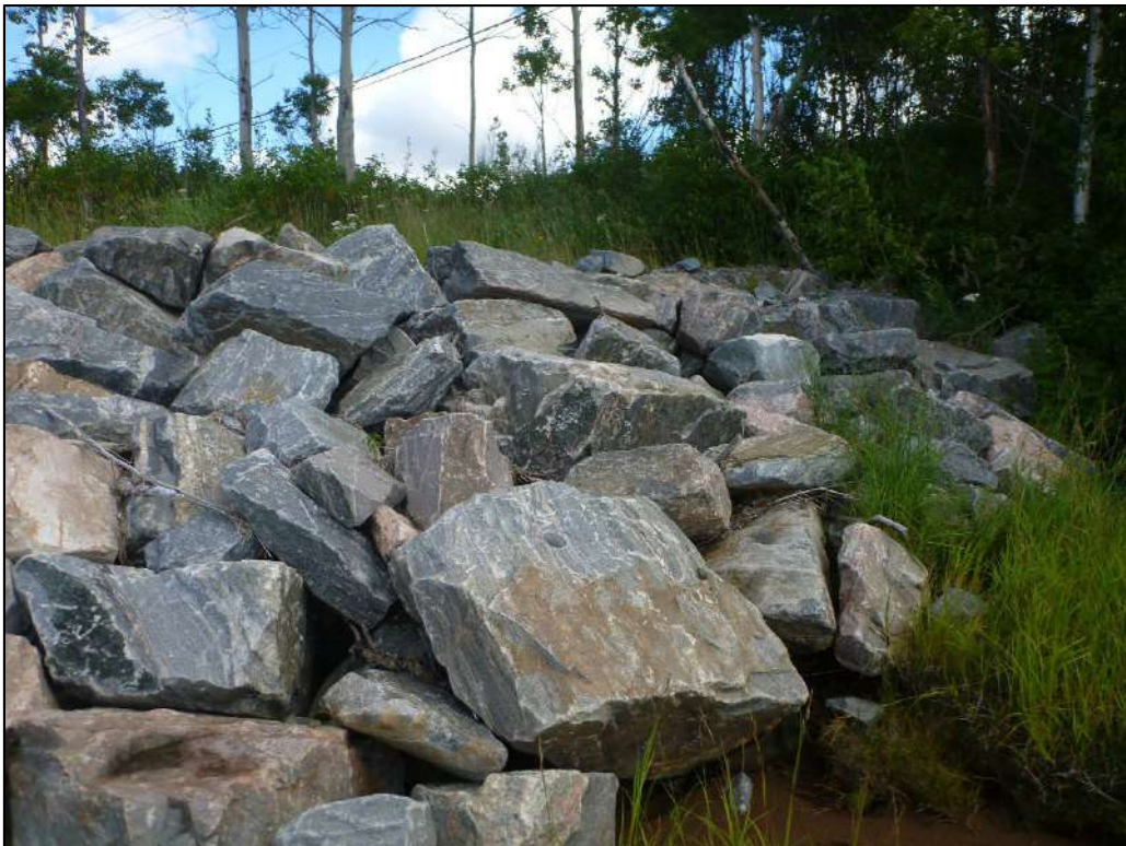
Photo 20. Point photographique 11P4 de l'herbier 11H1 – Vue vers la rive
