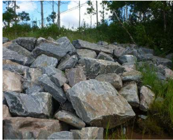
Photo 44. Point photographique 4 (11P4) de l'herbier H1 – Vue vers la rive
