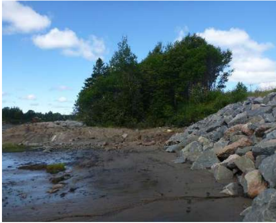
Photo 34. Point photographique 1 (11P1) à proximité de l'herbier H2 – Vue vers l'aval
