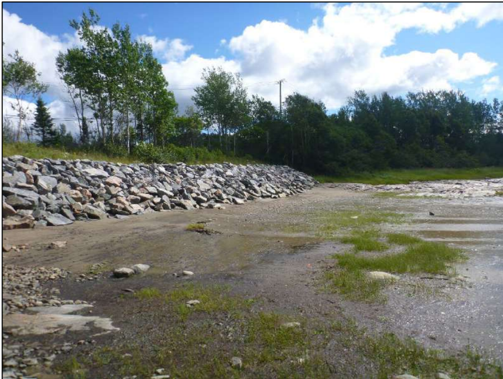
Photo 6. Vue d'une portion de l'herbier 11H3C
