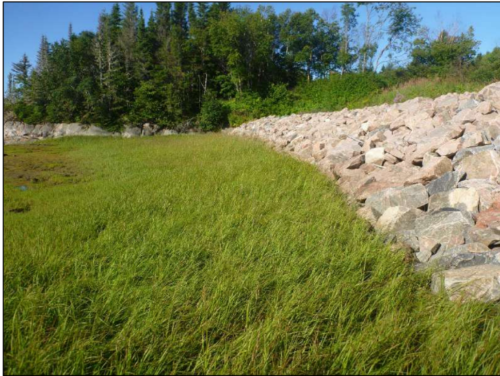
Photo 1. Vue générale sur l'herbier 4H1
