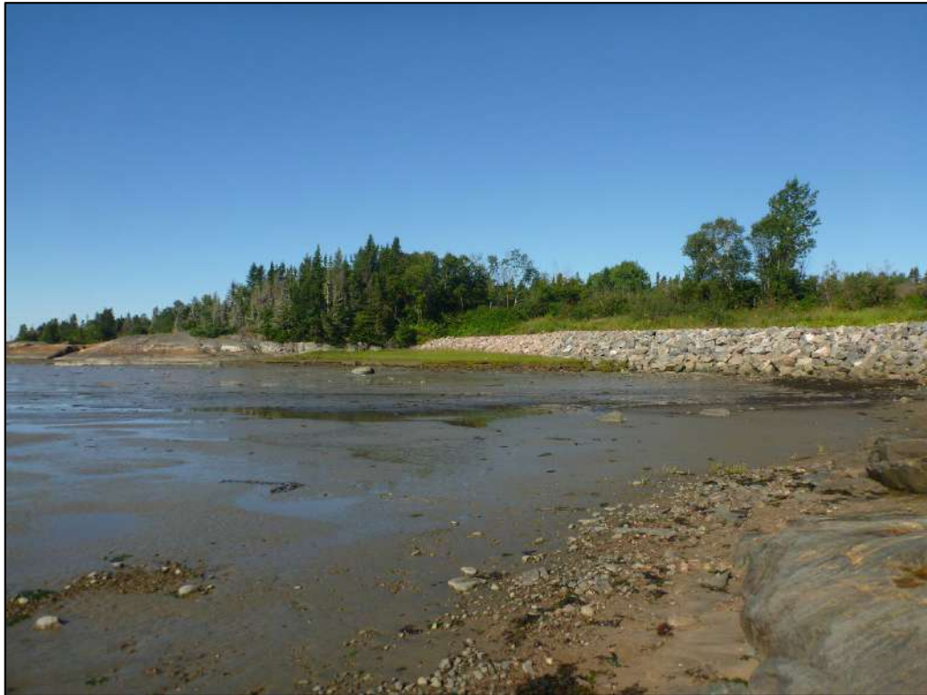
Photo 18. Point photographique 4P2 à proximité de l'herbier 4H3 – Vue vers l'aval
