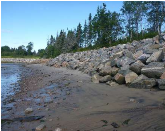
Photo 14. Point photographique 2 (4P2) de l'herbier H3 – Vue vers l'aval
