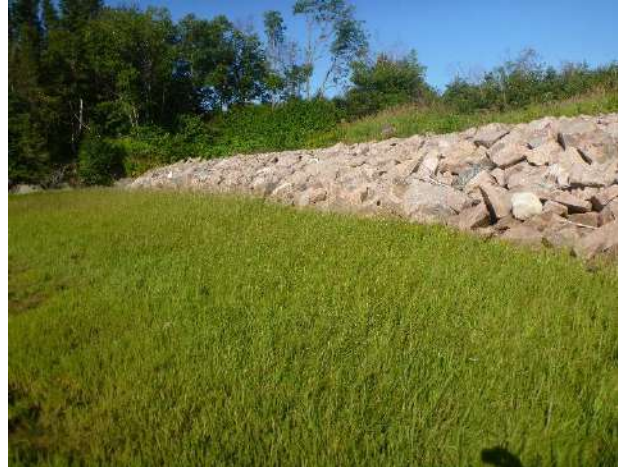
Photo 2. Vue sur une portion de l'herbier H1
