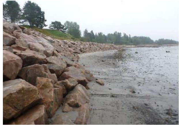
Photo 4. Plage de sable au pied de l'enrochement, Rag-2, 12 août 2021
