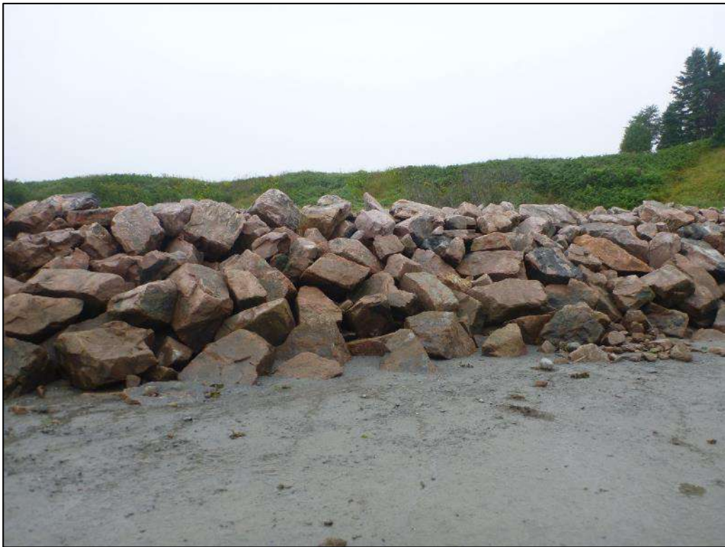
Photo 20. Point photographique 2P3 – Vue vers la rive, Rag-2
