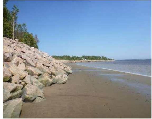
Photo 84. Point photographique 13P3 – Vue vers l’amont
