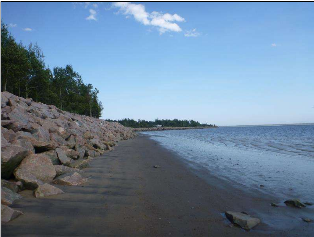
Photo 12. Point photographique 13P4 – Vue vers l'amont, Rag-13
