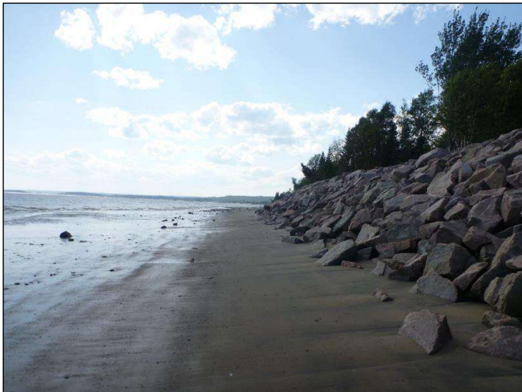
Photo 10. Point photographique 13P4 – Vue vers l'aval, Rag-13
