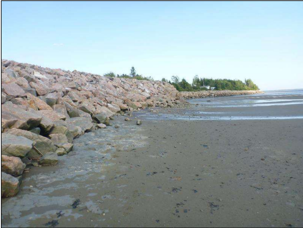
Photo 3. Point photographique 13P1 – Vue vers l’amont, Rag-13
