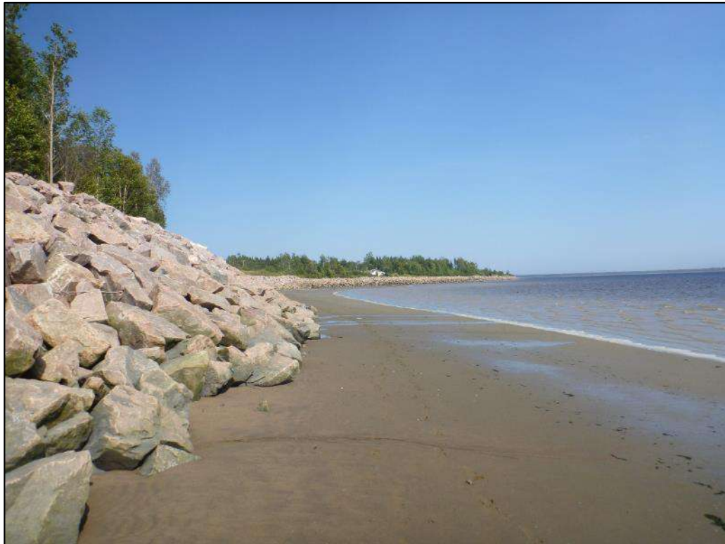
Photo 9. Point photographique 13P3 – Vue vers l'amont, Rag-13
