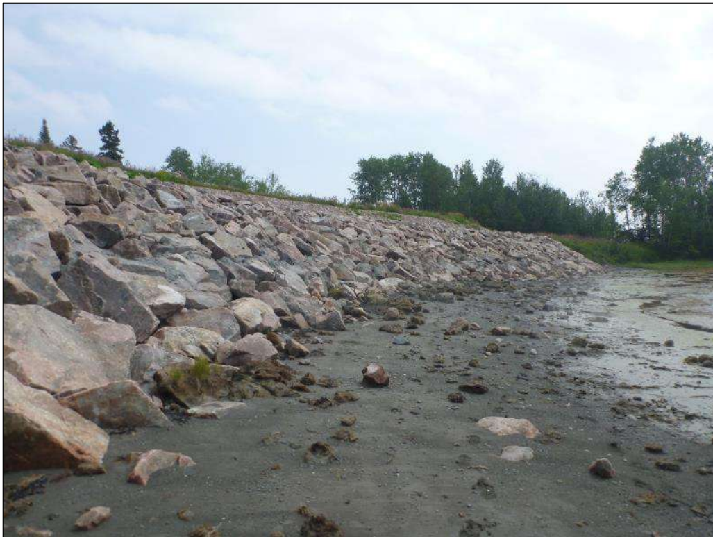
Photo 28. Point photographique 3P5 – Vue vers l'amont, Rag-3
