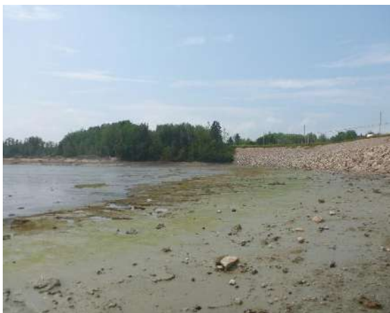
Photo 52. Point photographique 3P5 – Vue vers l'aval
