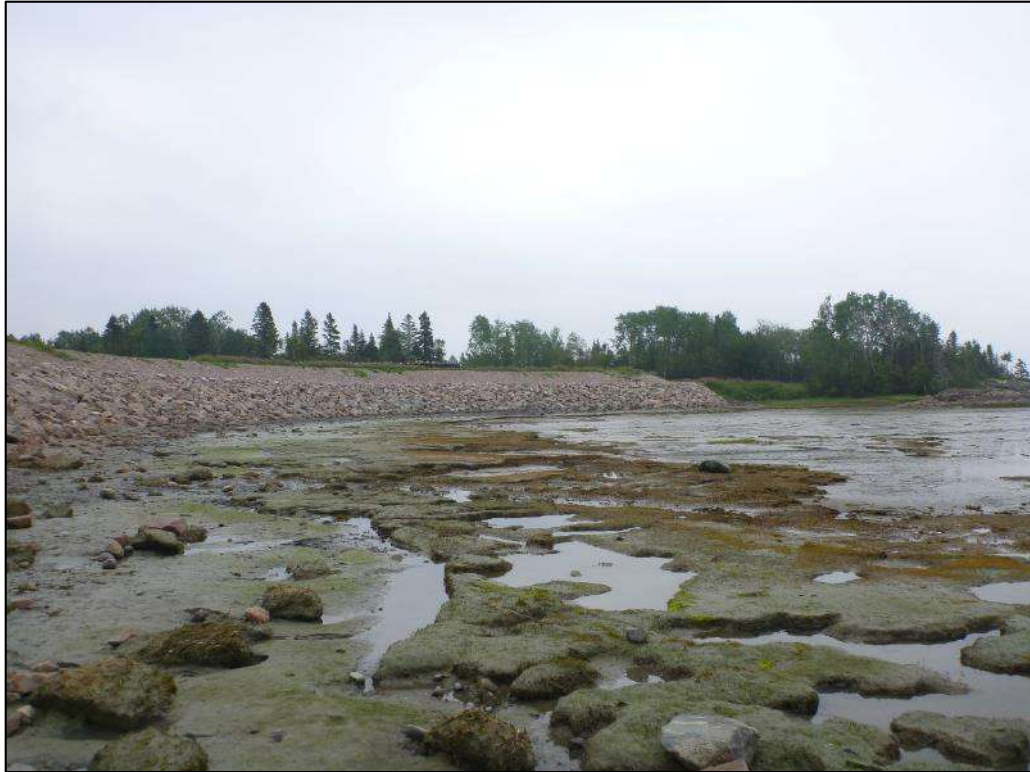
Photo 25. Point photographique 3P4 – Vue vers l'amont, Rag-3
