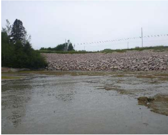
Photo 40. Point photographique 3P1 – Vue vers l'aval
