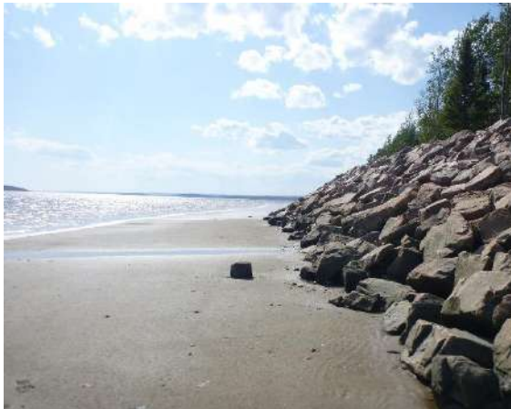
Photo 79. Point photographique 13P2 – Vue vers l’aval
