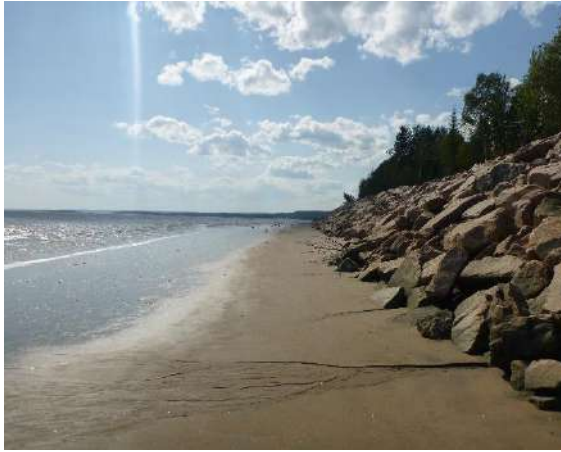
Photo 82. Point photographique 13P3 – Vue vers l’aval
