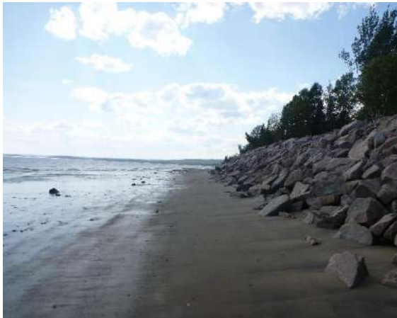
Photo 85. Point photographique 13P4 – Vue vers l’aval
