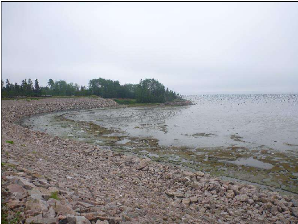
Photo 8. Vue d'ensemble de la section est de Rag-3
