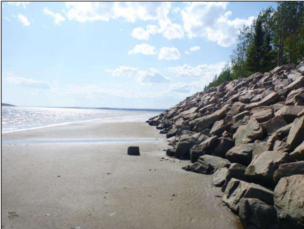
Photo 4. Point photographique 13P2 – Vue vers l’aval, Rag-13
