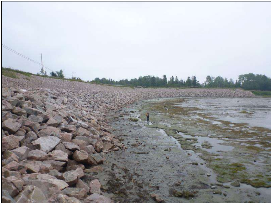
Photo 22. Point photographique 3P3 – Vue vers l'amont, Rag-3
