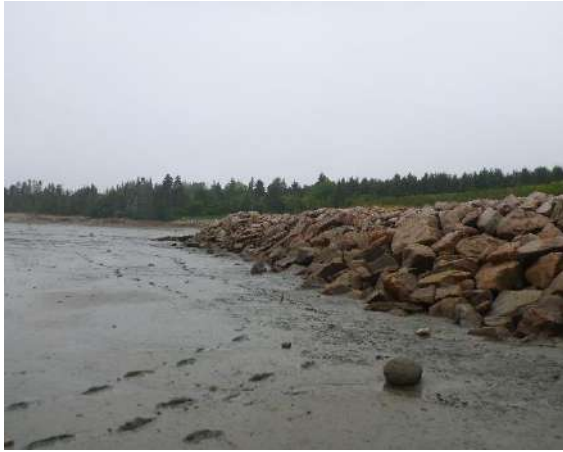
Photo 17. Point photographique 2P3 – Vue vers l'aval
