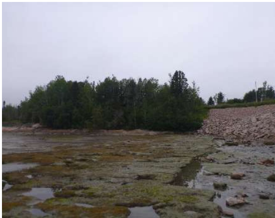
Photo 49. Point photographique 3P4 – Vue vers l'aval
