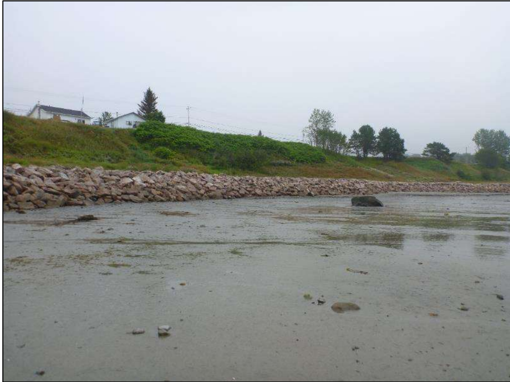
Photo 21. Point photographique 2P3 – Vue vers l'amont, Rag-2
