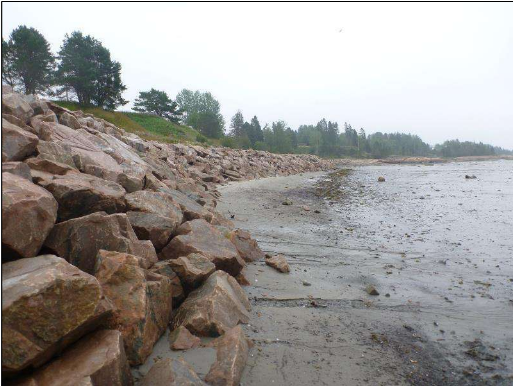
Photo 4. Plage de sable au pied de l'enrochement, Rag-2, 12 août 2021
