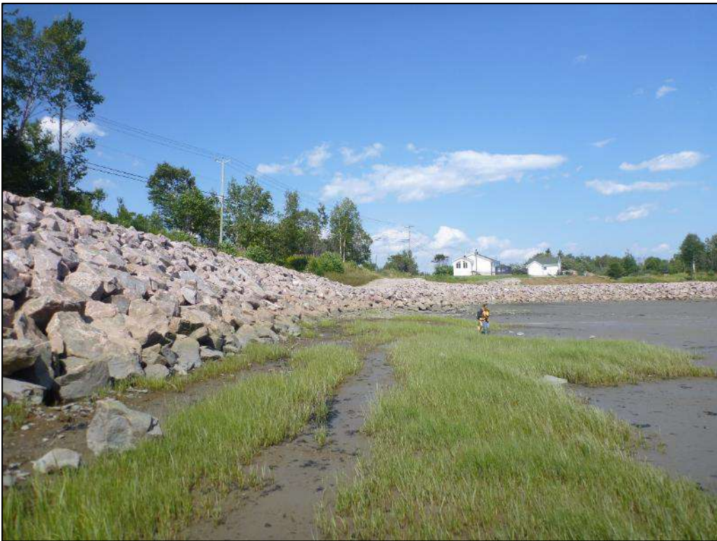
Photo 24. Point photographique 6P3 – Vue vers l'amont, Rag-6
