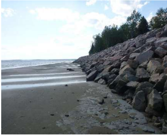
Photo 76. Point photographique 13P1 – Vue vers l’aval
