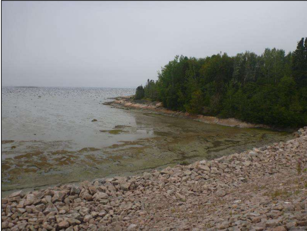
Photo 7. Vue d'ensemble de la section ouest de Rag-3
