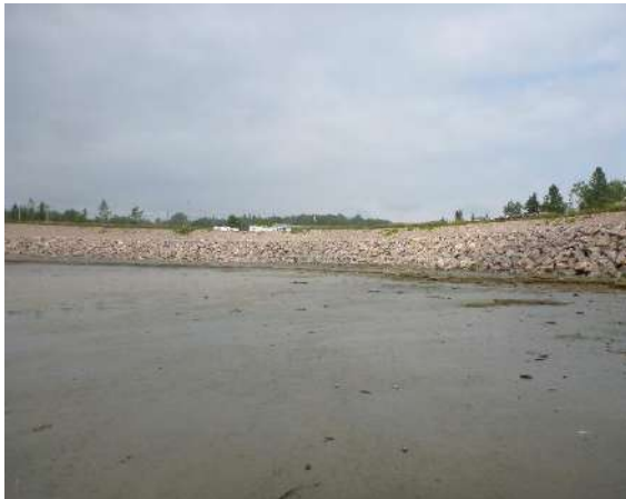
Photo 43. Point photographique 3P2 – Vue vers l'aval
