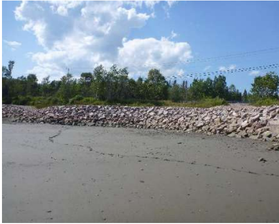
Photo 67. Point photographique 6P1 – Vue vers l’aval
