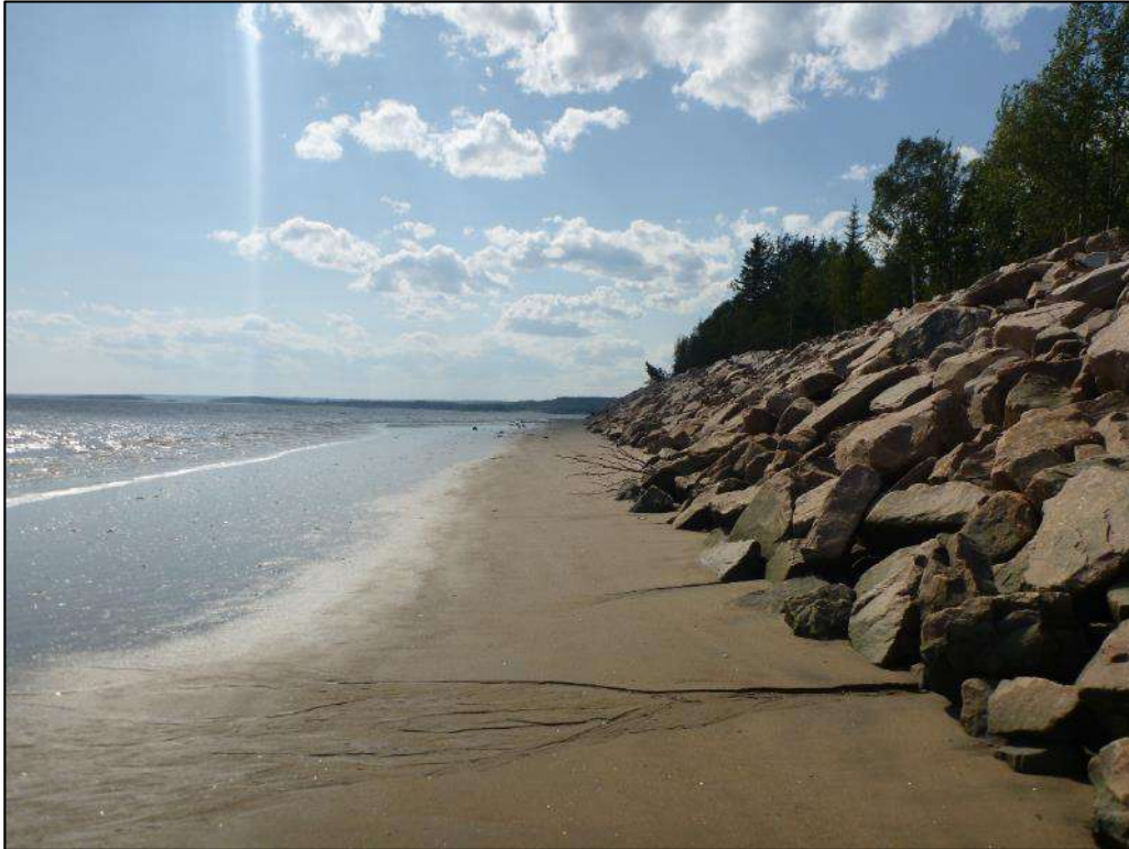
Photo 7. Point photographique 13P3 – Vue vers l’aval, Rag-13
