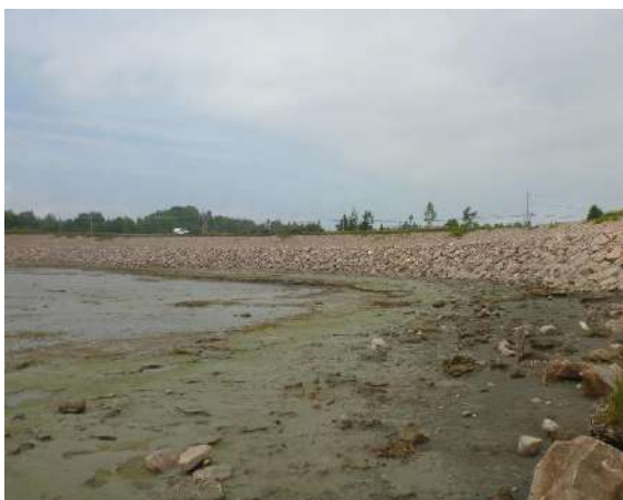
Photo 55. Point photographique 3P6 – Vue vers l'aval
