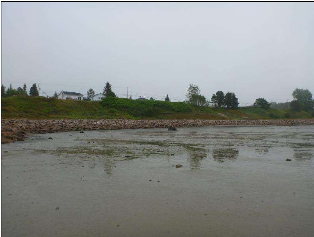
Photo 24. Point photographique 2P4 – Vue vers l'amont, Rag-2
