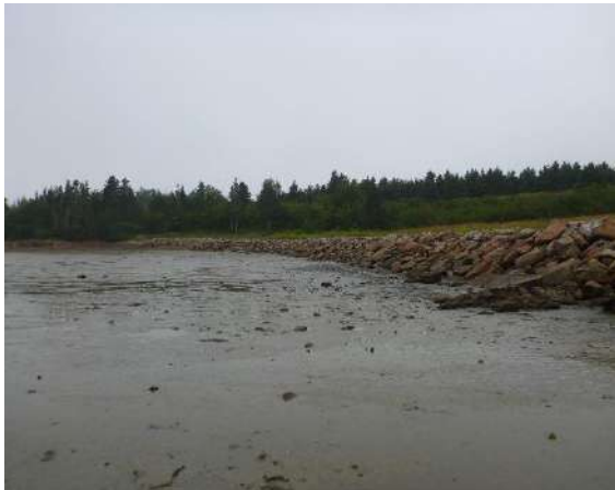
Photo 20. Point photographique 2P4 – Vue vers l'aval
