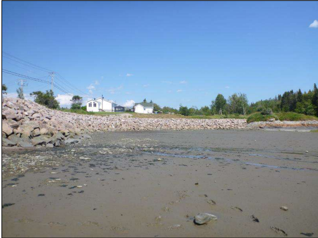
Photo 21. Point photographique 6P2 – Vue vers l'amont, Rag-6
