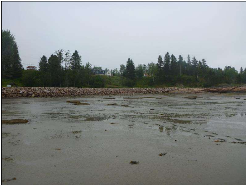
Photo 18. Point photographique 2P2 – Vue vers l'amont, Rag-2
