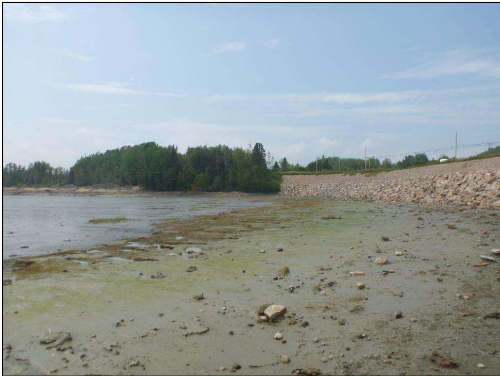
Photo 26. Point photographique 3P5 – Vue vers l'aval, Rag-3
