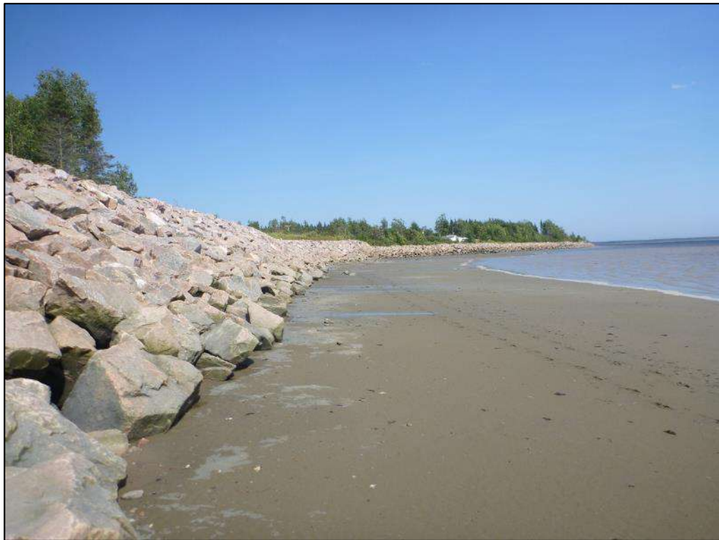
Photo 6. Point photographique 13P2 – Vue vers l'amont, Rag-13
