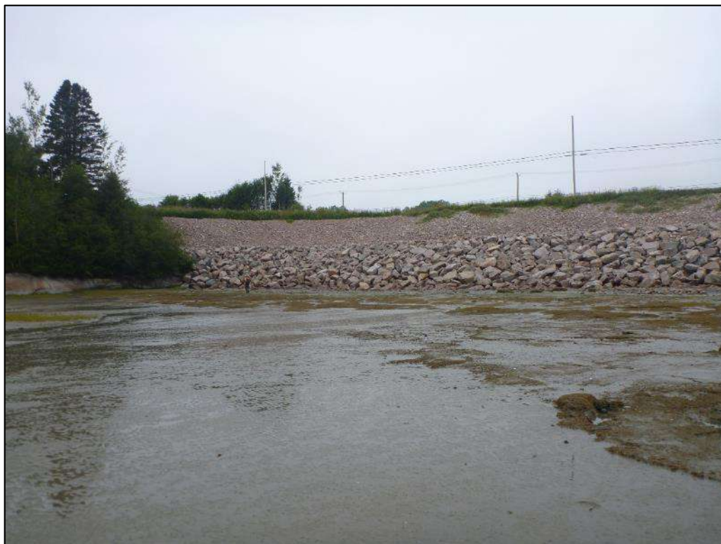
Photo 14. Point photographique 3P1 – Vue vers l'aval, Rag-3
