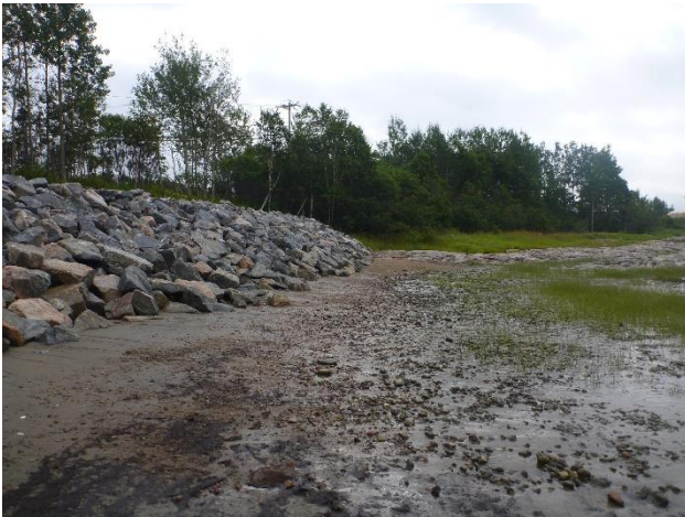
Photo 30. Enrochement à l'emplacement de l'herbier H2
