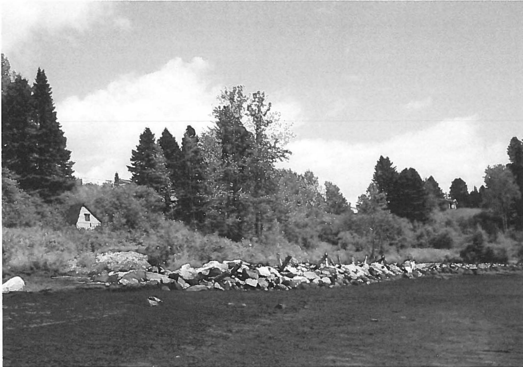
Photo 3 : Enrochement existant à l'extrémité Est de RAG-2A. On peut apercevoir les pieux de bois qui ressortent à angle à travers les pierres.
