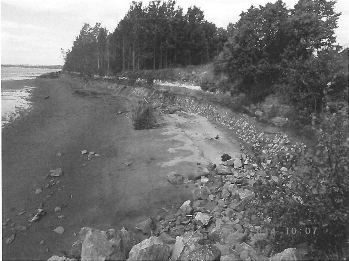
Photo 12 : RAG-13, zone érodée à l'extrémité Ouest de la protection existante.
