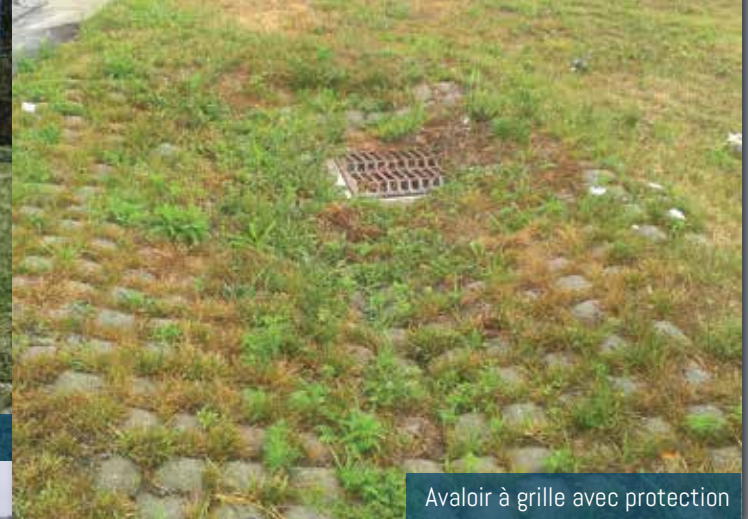
Exutoire protégé avec Flexamat®, 3 ans après l'installation.
