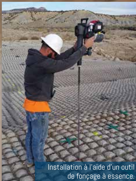
Fixation de l'ancrage avec l'outil Jack Jaw®
