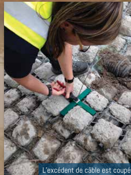
Fixation de l'ancrage avec l'outil Jack Jaw®
