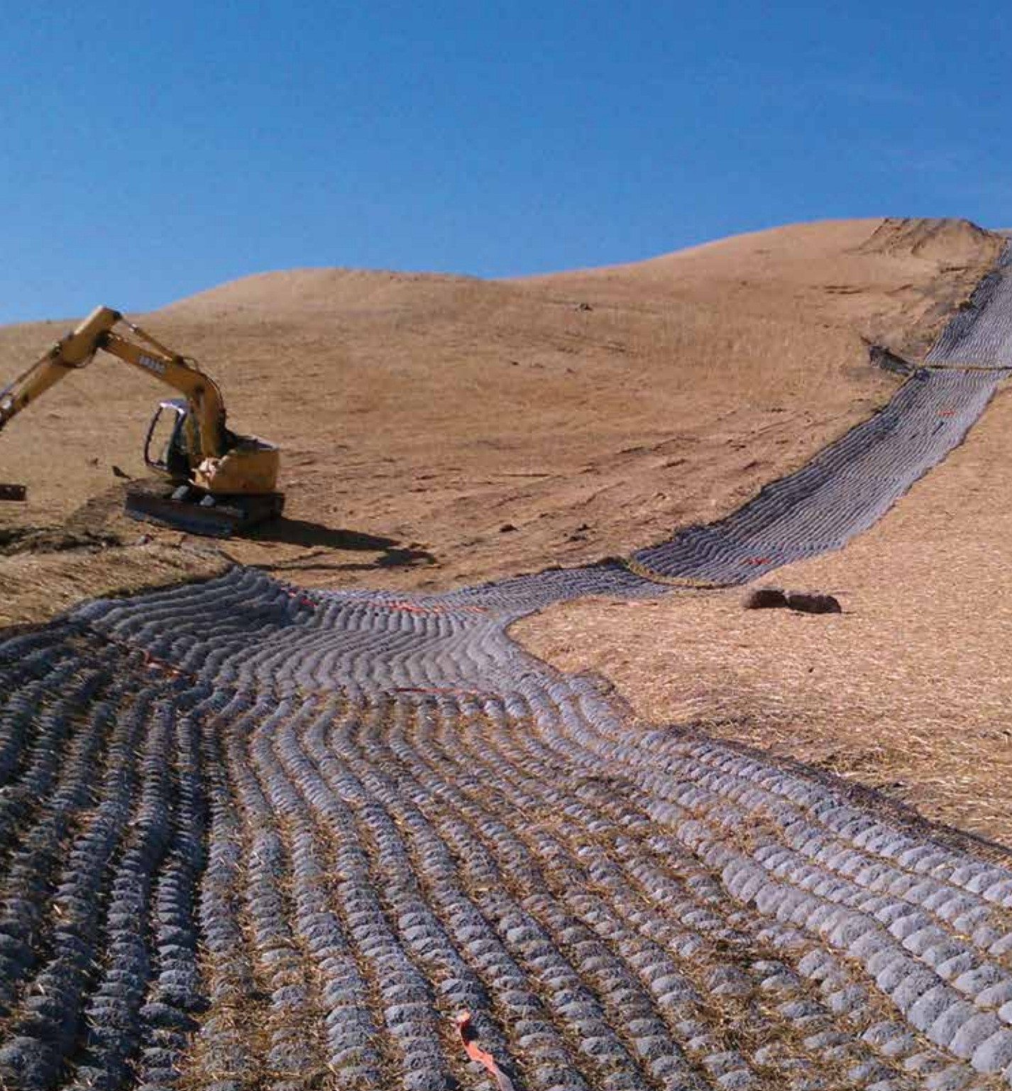
Descente d'une largeur de 60 pi venant d'être installée.
