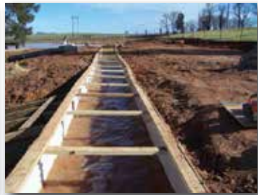
Débit par gravité dans le canal jaugeur
