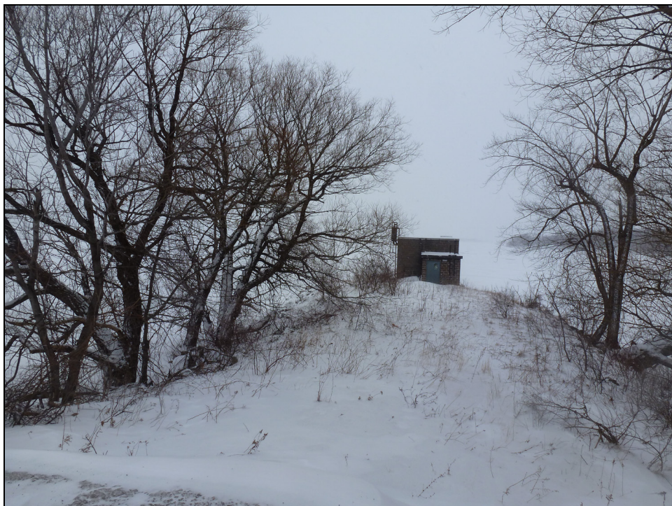
Photo n° 8 : Limite de l'axe 2 et de l'axe 3 de la berge. Vue en direction nord. Station de pompage. (2013-02-20)
