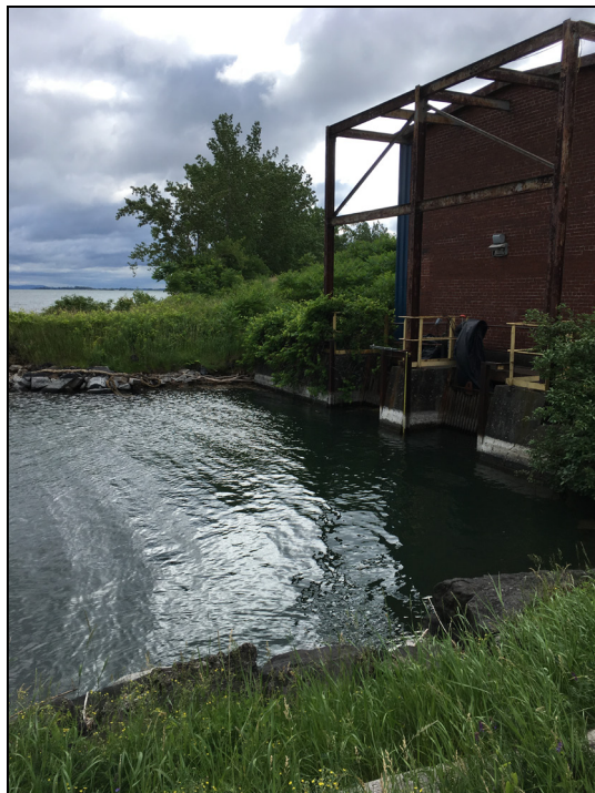
Photo n° 4 : Limite entre l'axe 1 et l'axe 2 de la berge. Vue en direction est. Ancienne station de pompage. (2017-06-27)
