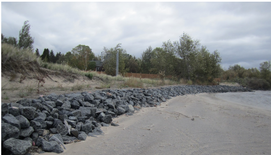
Secteur 3 : Perré à la base de la digue submergée (24 sept. 2020) Élévation du lac : 100,94 m (14,5 pi).
