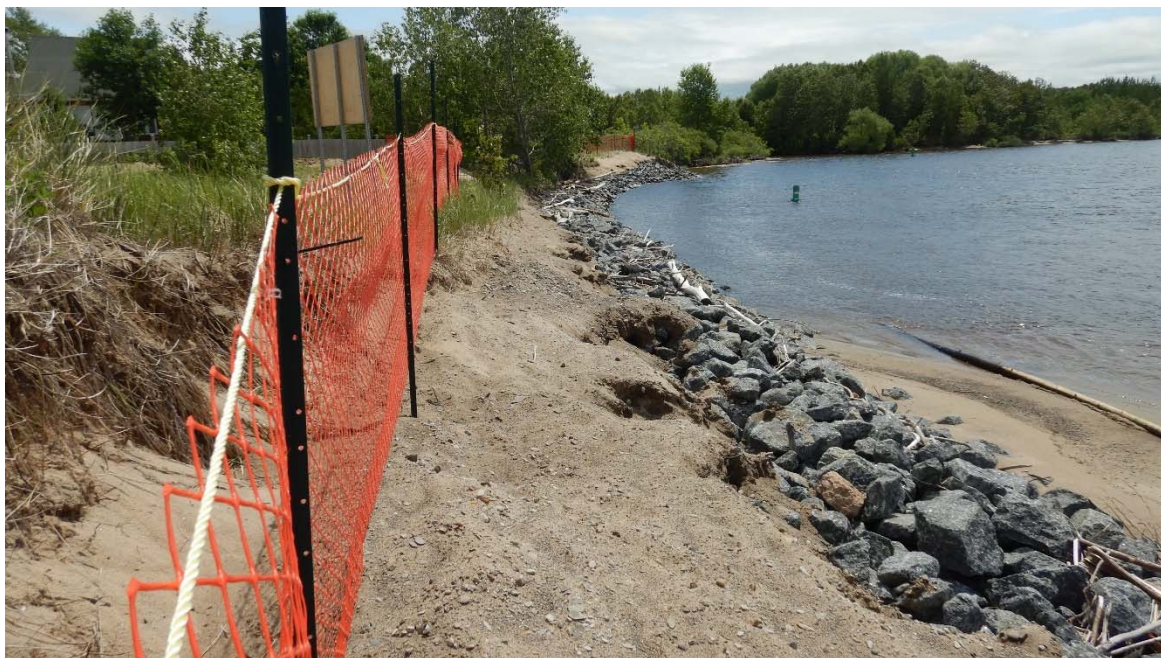
Secteur 3 : Perré à la base de la digue submergée (12 juil. 2019) Élévation du lac : 101,24 m (15,52 pi).
