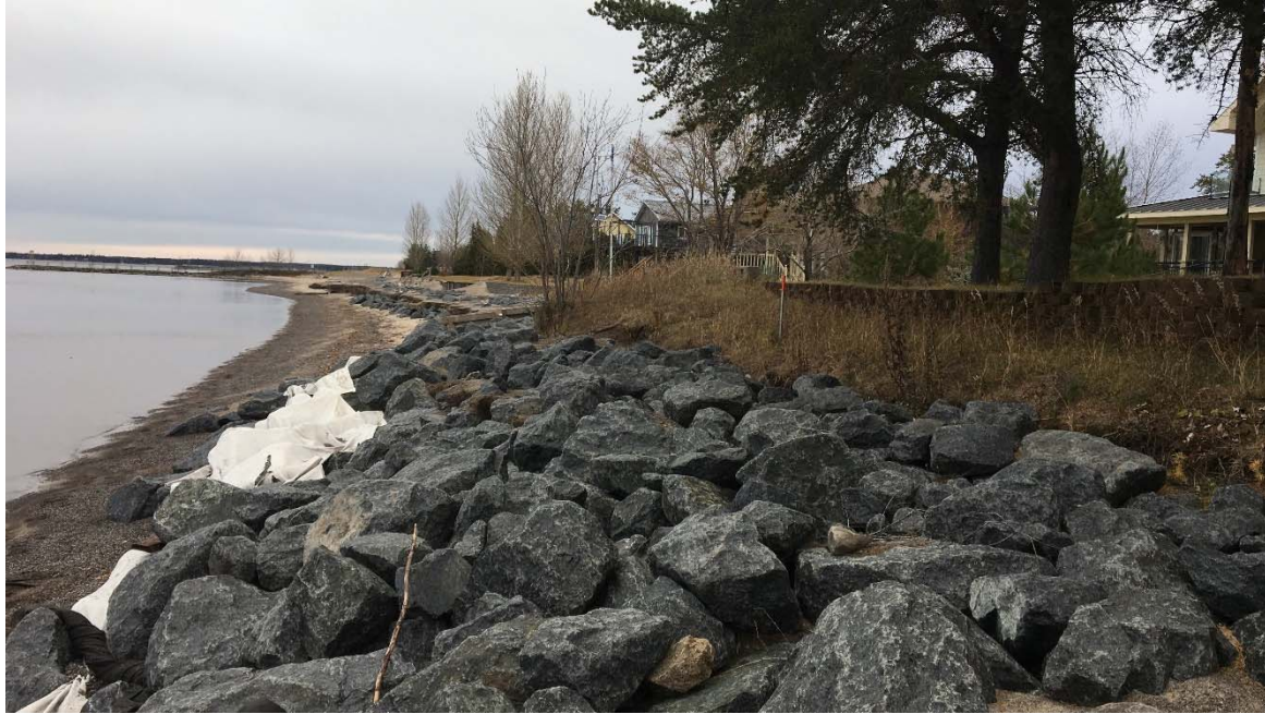
Secteur 2 : Vue devant le perré de support (5 nov. 2018) Élévation du lac : 101,06 m (14,93 pi).
