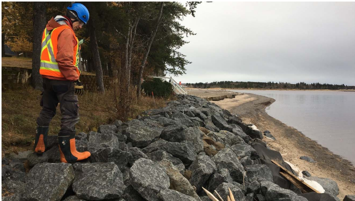
Secteur 2 : Vue devant le perré de support (5 nov. 2018) Élévation du lac : 101,06 m (14,93 pi).
