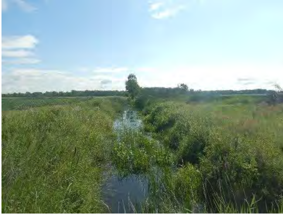
Figure 3.3 Décharge des Trente – vue vers l'aval
