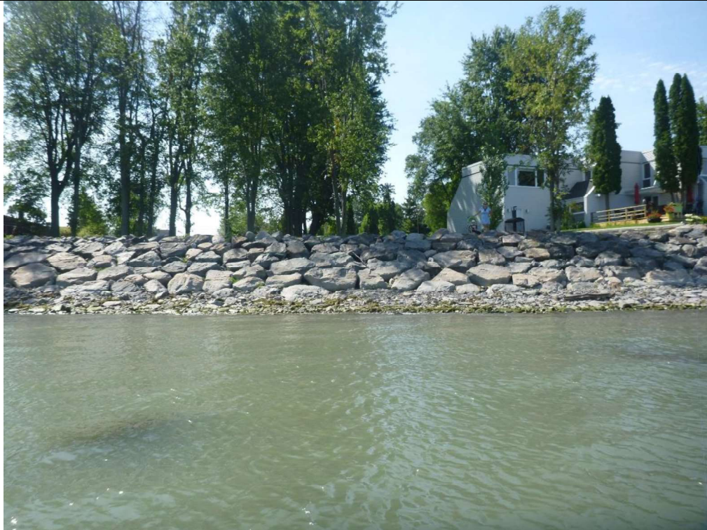
PHOTO 1 Berge à l'endroit où débutera la conduite
