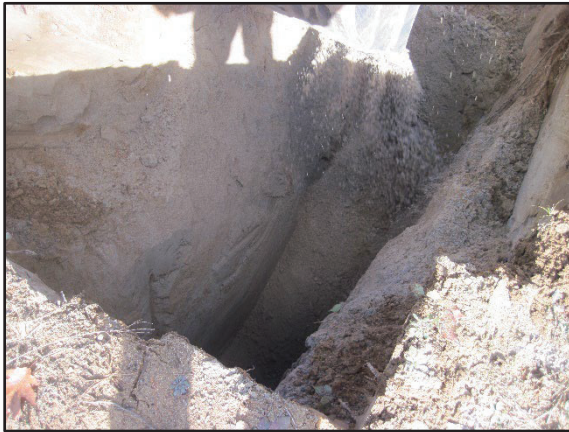
Photo 7 Tranchée exploratoire au point WP011 sur une profondeur de plus de 3 mètres.
