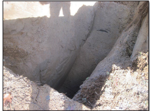
Photo 8 Tranchée exploratoire au point WP013 sur une profondeur de plus de 3 mètres.
