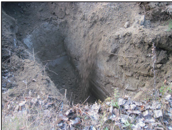
Photo 9 Tranchée exploratoire au point WP015 sur une profondeur de plus de 3 mètres.
