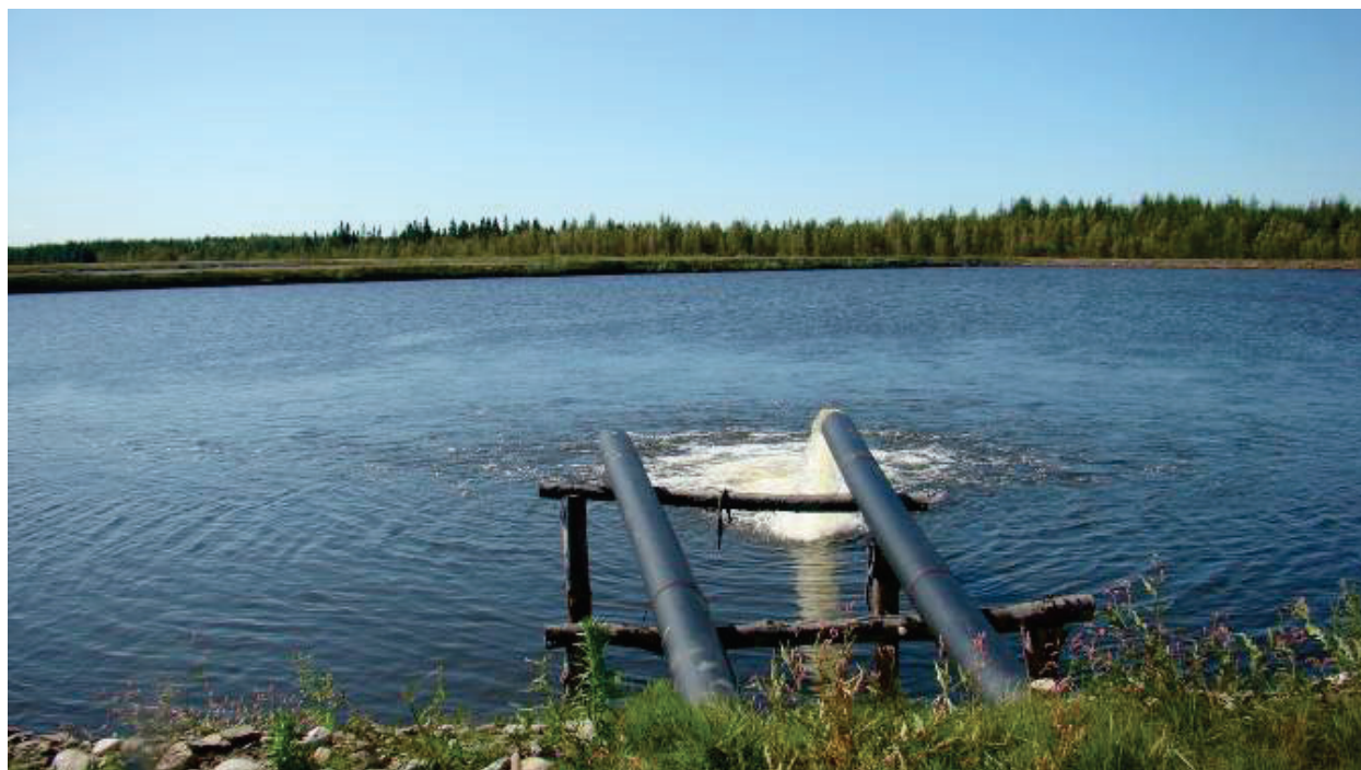
Figure 5. Bassin de récupération (surface)
