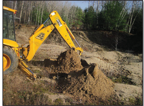
Photo 6 Tranchée exploratoire à proximité du point WP008 et à 3 mètres sous la hauteur du terrain naturel. La nappe a été observée à environ 1,40 m de profondeur.
