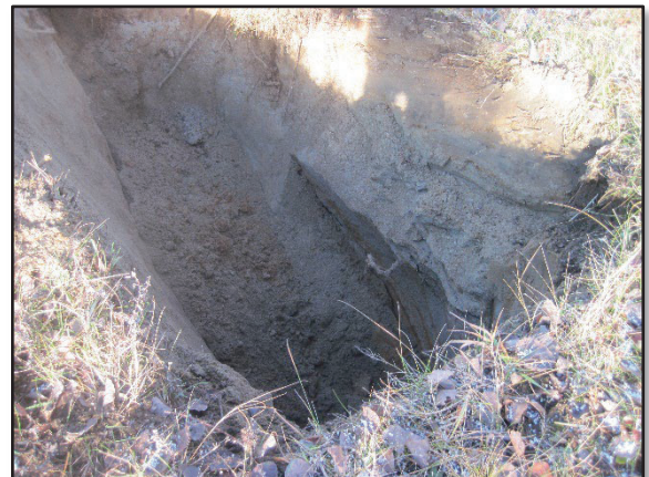
Photo 10 Tranchée exploratoire au point WP016 sur une profondeur d'environ 2,5 mètres.
