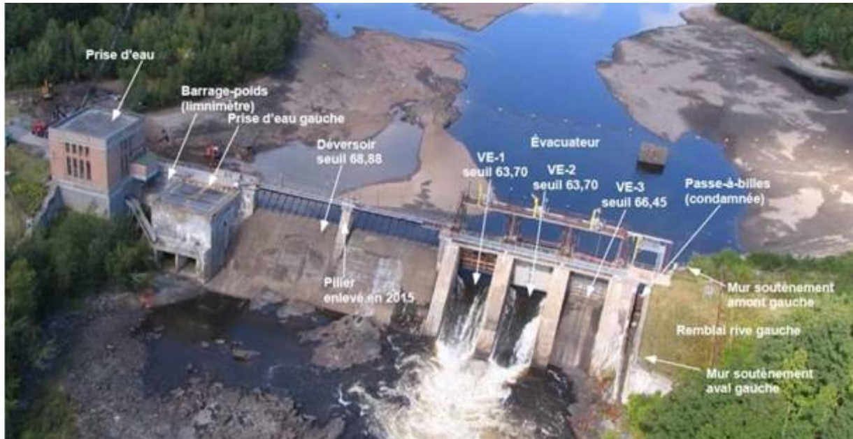
Figure 1 – Composantes du barrage de Saint-Narcisse
